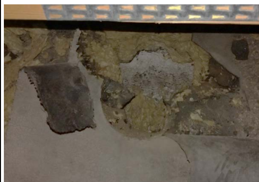
Kuva 17. Kattohuovat, alushuopa ja vedeneristepiki villan alta, alkuperäinen vesikatto, näytteet 14, 15 ja 16.
