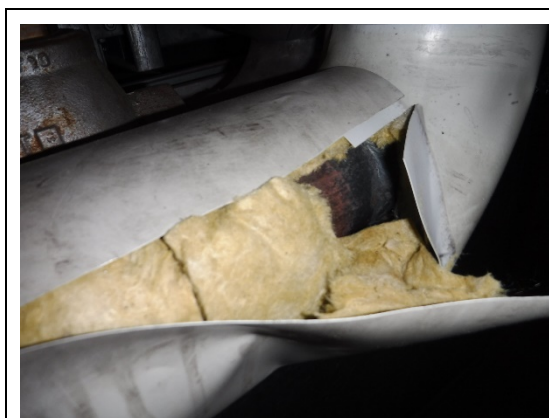
Kuva 2. LVIS tekniikassa ei havaittu asbestipitoisia materiaaleja.
