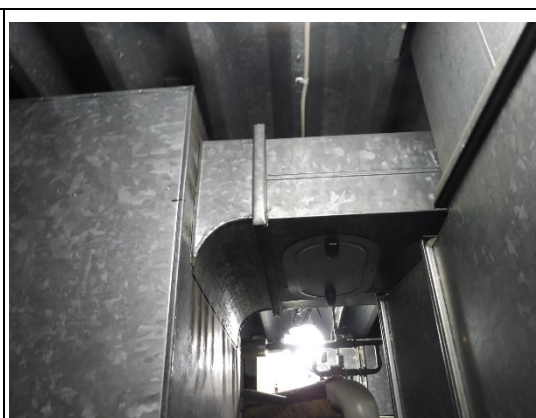
Kuva 3. LVIS tekniikassa ei havaittu asbestipitoisia materiaaleja.
