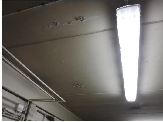
Kuva 22. Kattomaalit, betoni yläpohjat, näyte 4.
