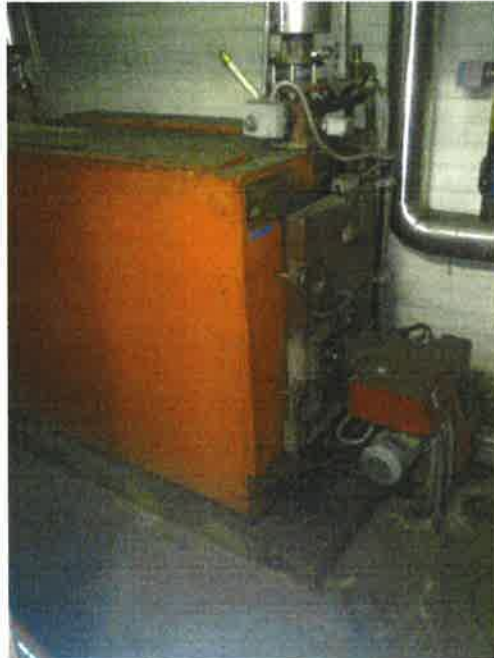
Kattila jo teknisen käyttöikänsä päässä, kts. myös lämpökuvat
