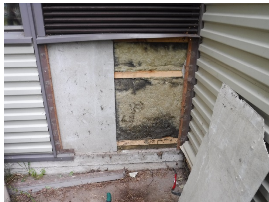
Kuva 6. Julkisivun tuulensuojalevy 3 mm, näyte 3.
