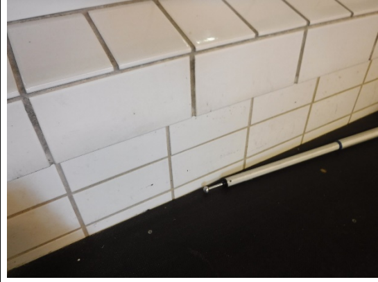
Kuva 11. Sauma- ja kiinnityslaasti, 100*190 mm valkoinen seinälaatta, uima-allashuone, näyte 8.
