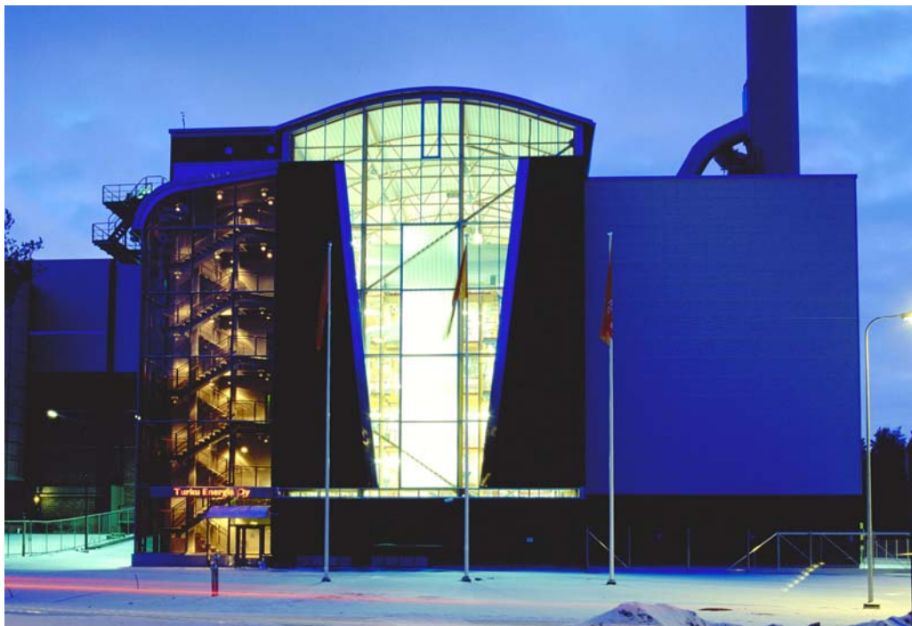
Oriikedon Biolämpökeskus tuottaa puhdasta lämpöä turkulaisiin koteihin. Kuva: Turku Energia Oy, Esko Keski-Oja
