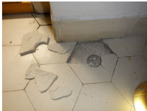
Kuva 3.2.3 1. krs. WC-tila, lattiaan rakenteen avaus.
