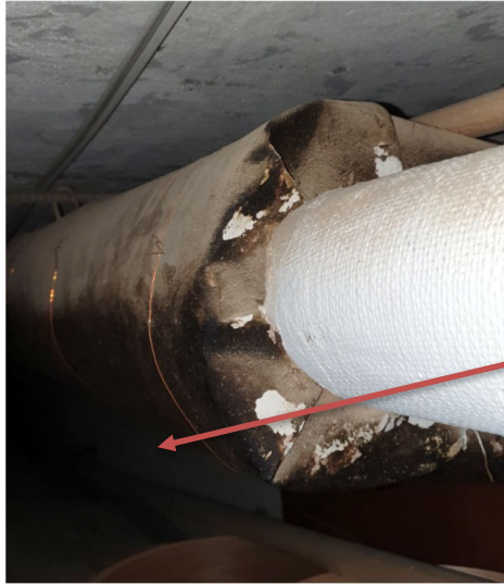
Kuvat 3.1.1 Putken massaeriste sisältää kokemuksellista ja aistinvaraisen havainnon perusteella vaaleaa asbestia.
