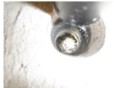
Kuva 3.2.4 1. krs. WC-tila, lattiaan pintabetonilaatan alla pikisively+bitumikermit – sementtilastuvillalevy – pikisively – pohjabetonilaatta. Näyte ASB9 pikisive-lystä ja bitumikermitistä. Pikisiveilyssä on asbestia (antofylliitti).
