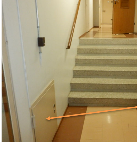
Kuvat 3.1.5 Käytävältä johtaa luukku varastotilan alapuolelle onkalotilaan.
