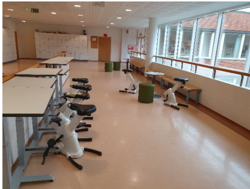
Kuva 3.2.7 2. krs. lattian vaalea kvartsivinyyli-laatta. Näyte ASB 34 kvartsivinyylilaatasta, mustasta liimasta ja tasoitteesta, porrashuonetilasta. Mustassa liimassa on asbestia (antofylliitti).
