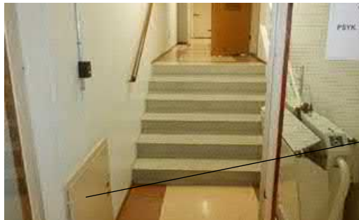
Kuva 6.6.2. Alapohjan onkalotilan tarkastus koulutaraston viereisen portaikon kohdalla.
