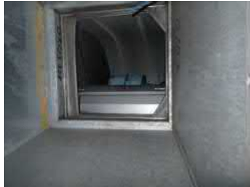
Kuva 7.1.10. Tuloilmarunkokanavistossa ei ollut merkittävästi pölyä.
