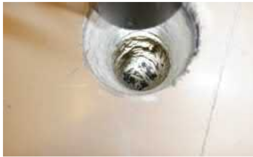
Kuva 6.1.9. AP-rakenteen tarkastus \varnothing 32 mm varastotilassa.
