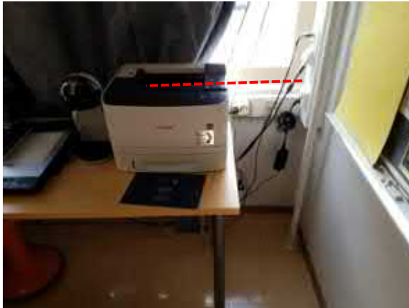
Kuva 6.2.3. Ilmavuotoa luokassa 228 ikkunaliittymistä ja lattia-rajasta.
