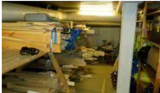
Kuva 5.1.2. Yleiskuvaa alempaan kellarikerrokseen. Kattopintana teräsprofiililevy (liittolaatta).
