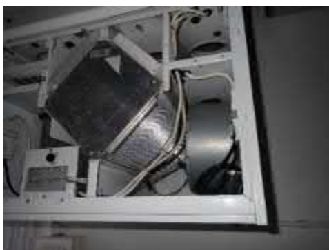
Kuva 7.1.20. Vanha talonmiehen asunnon kone oli sisältä puhdas.
