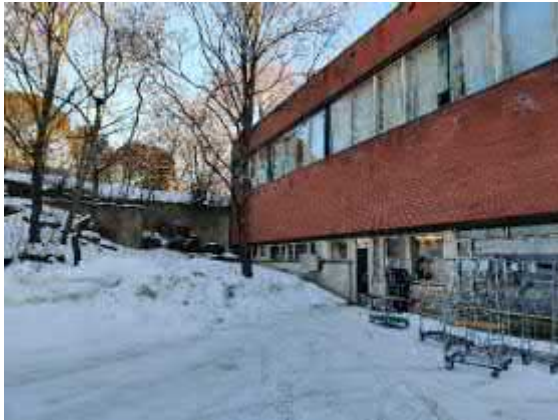
Kuva 3.1.4. Osa III on louhittu kalliorinteeseen osittain maanpinnan alapuolelle.
