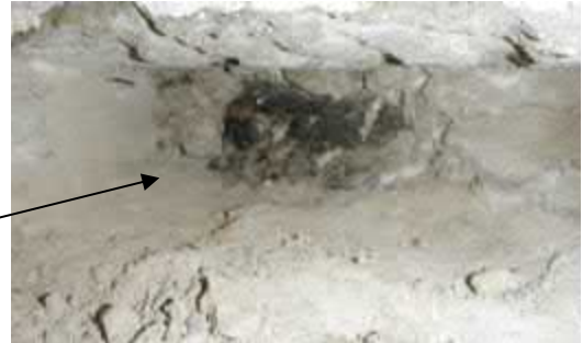
Kuva 6.1.23. Avaus ulotettiin perusmuuriin sisäpinnan betonirakenteeseen.
