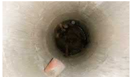
Kuva 6.1.12. Tarkastetuissa kaivoissa ei havaittu viitteitä salaojien toimimattomuudesta.
