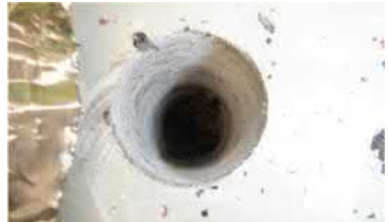
Kuva 6.1.5. AP-rakenteessa ei ollut eristetilaa, eikä orgaanista materiaalia.
