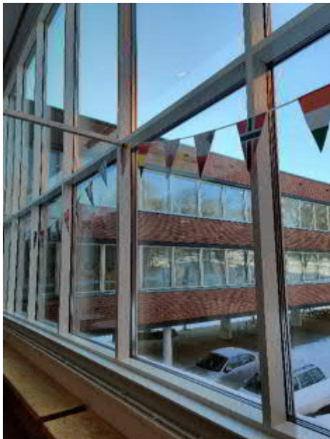
Kuva 6.2.10. Aulatilán ikkunat on uusittu lähiaikoina.
