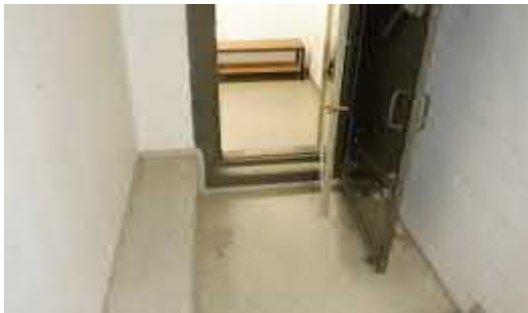
Kuva 5.2.2. Kellarin lattia ja seinien maalipinnoitteissa ei havaittu liiallisen kosteuden aiheuttamia pinnoitevaurioita.
