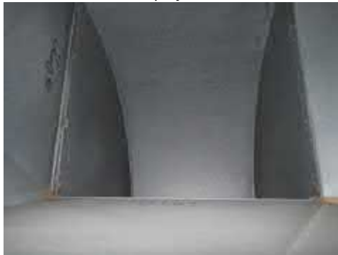
Kuva 7.1.6. Tuloilmarunkokanavistossa ei ollut merkittävästi pölyä.
