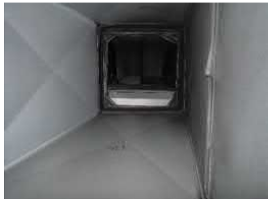
Kuva 7.1.8. Tuloilmarunkokanavistossa ei ollut merkittävästi pölyä.
