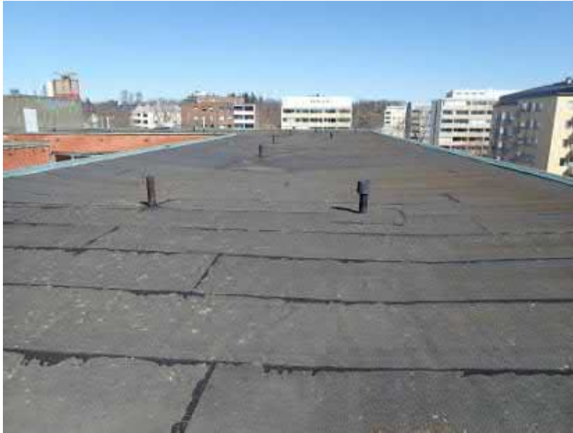
Kuva 6.3.3 Yleiskuva vesikatolta. Huopakatteessa tai läpivienneissä ei havaittu näkyviä vaurioita. Huopakate on todennäköisesti elinkaarensa lopussa.
