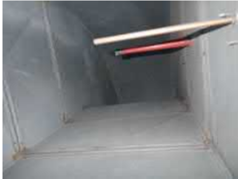
Kuva 7.1.18. Tuloilmakanavistossa ei ollut merkittävästi likaa.
