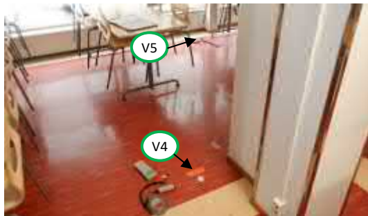
Kuva 5.3.10. Viiltokosteusmittauspisteet V4 ja V5 ruokalan laajennusosan alueella.
