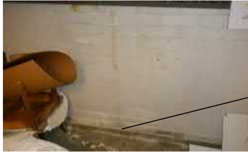
Kuva 6.1.22. Maanpaineseinän rakennetarkastus kellarin varastotilassa.
