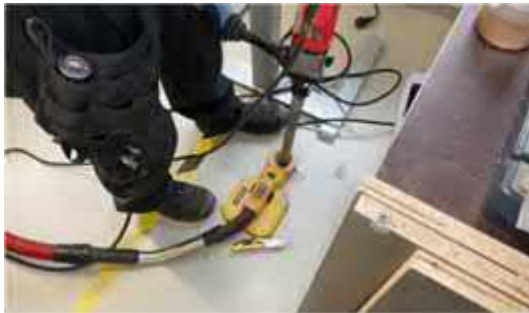
Kuva 6.1.4. AP-rakenteen tarkastusporaus \varnothing 32 mm metallityöluokassa.
