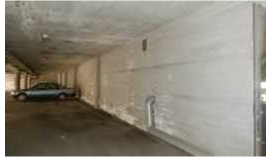
Kuva 6.6.11. Putkitunnelin sisäverhoukseen muurattun ulkoseinän takana on autohalli.
