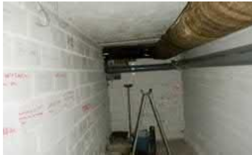
Kuva 6.6.14. Putkitunnelin pääty rakennuksen I-osan alapuolella.
