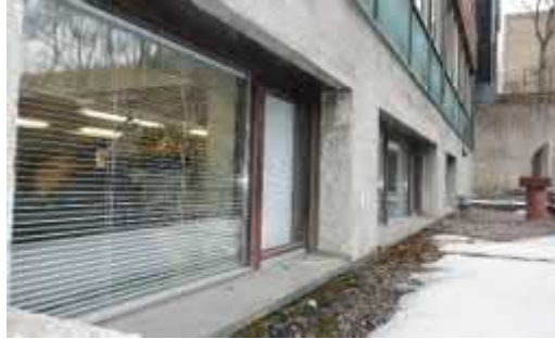
Kuva 6.1.18. Kellarikerroksen ulkoseinää itä-sivun alueella.
