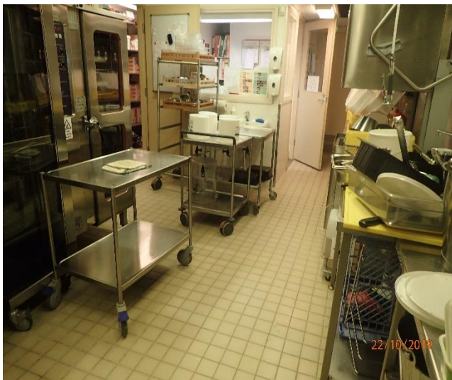
Keittiö on tyydyttävässä kunnossa.
