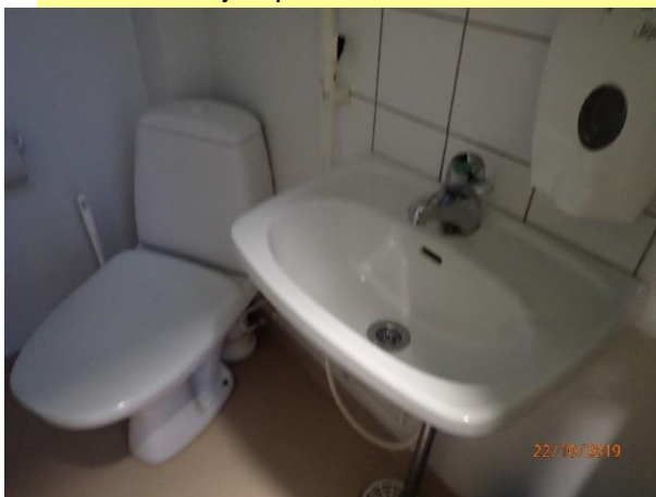
Saniteettitilat ovat tyydyttävässä kunnossa.
