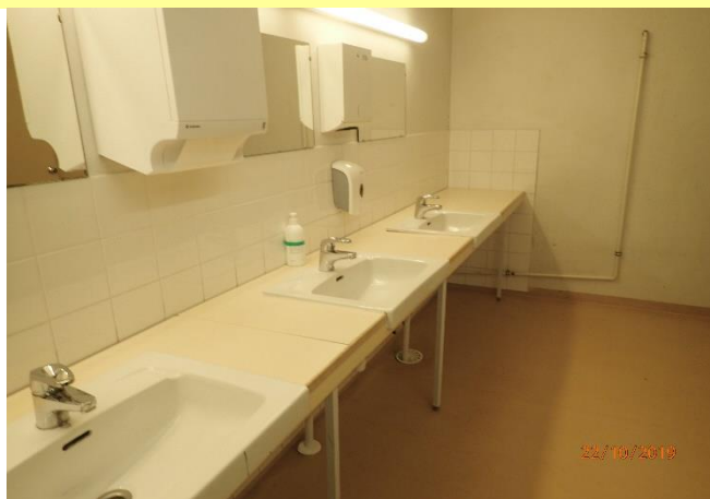
Saniteettitilat ovat tyydyttävässä kunnossa.
