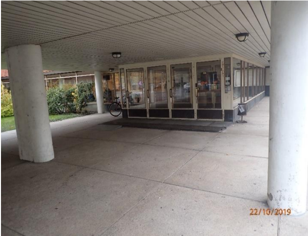
Pääsisäänkäyntien ulko-ovet ovat alkuperäiset.
