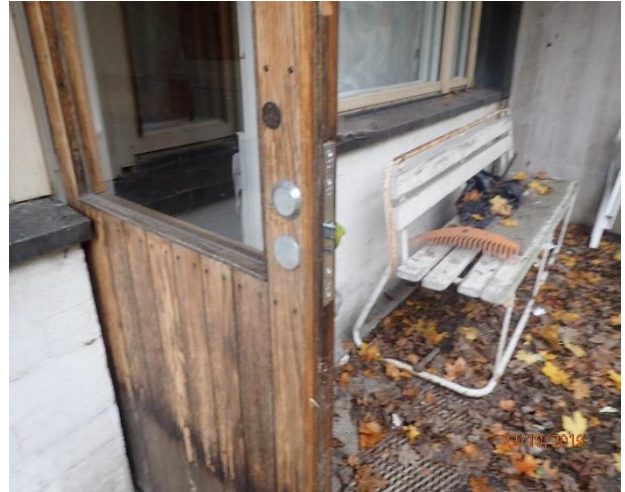
Vähemmällä käytöllä olevat ovet, ovat puurakenteisia.
