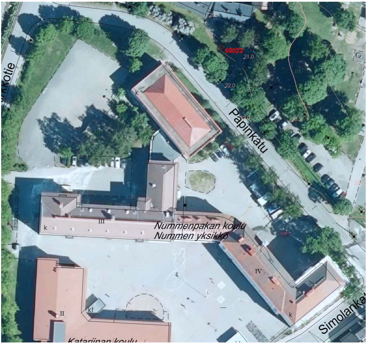
Kuva 1. Peruskorjattavat koulurakennukset sekä liikuntasali
