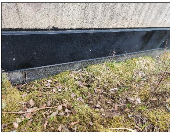
Kuva 5.3. Itäsivun sokkeliä on korjattu.
