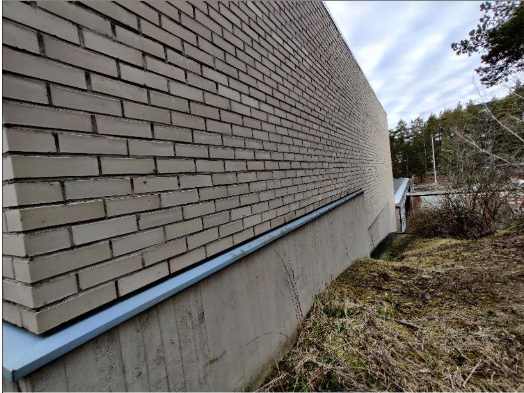
Kuva 5.2. Liikuntasalin julkisivuissa ei ole näkyviä kosteusrasituksen merkkejä (kuva liikuntasalin itäsivulta).
