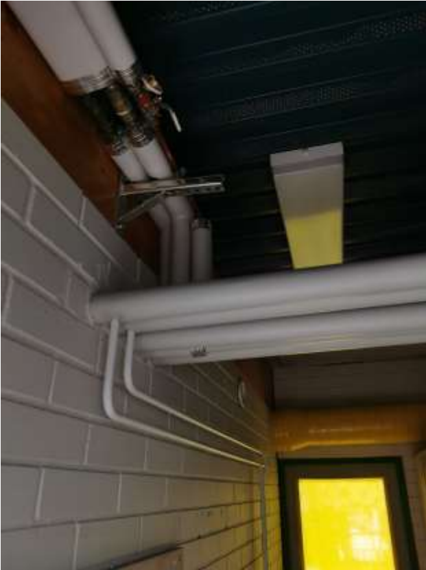
Kuva kohteen putkien eristeistä.
