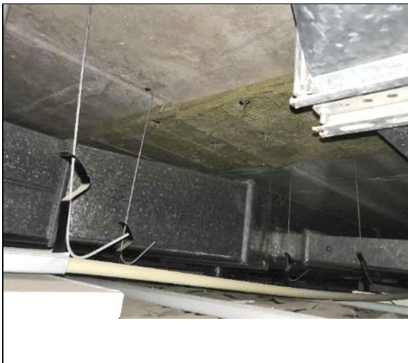
Kuva 5.74. Alakaton päällä on paikoin paljaita mineraalivillaeristeitä
