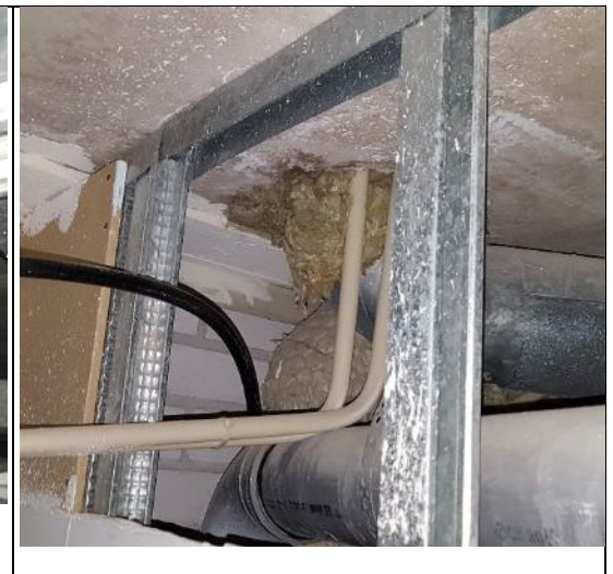
Kuva 5.73. Alakattojen päällä on erittäin runsaasti pölyä ja kuitulähteitä äänenvaimennuspusseissa.
