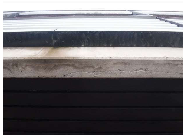
Betonipalkkia alhaalta kuvattuna
