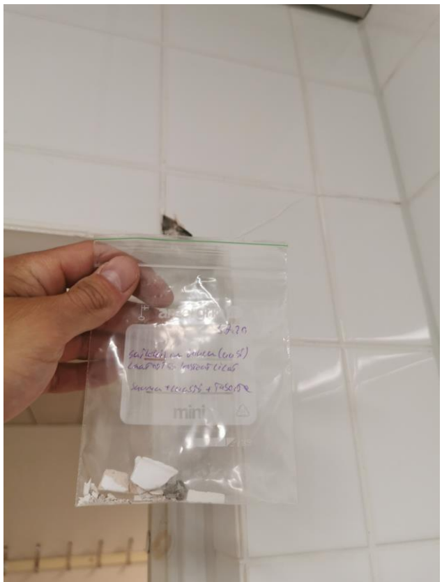
Kuva kosteantilan laatoituksen näytteen otosta.
