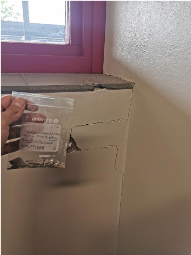
Kuva ikkunapenkin näytteen otosta.
