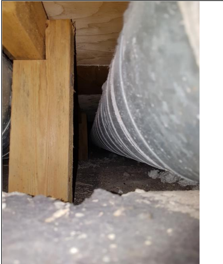
Kuva 5.67. Liikuntasiiven alapohjan putkikanaalissa ei aistinvaraisesti todettu vikaa.
