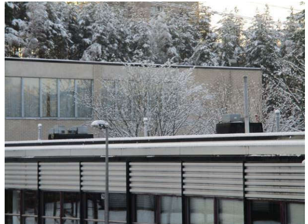
Vesikatolla on tarpeenmukaiset kohdepoistot
