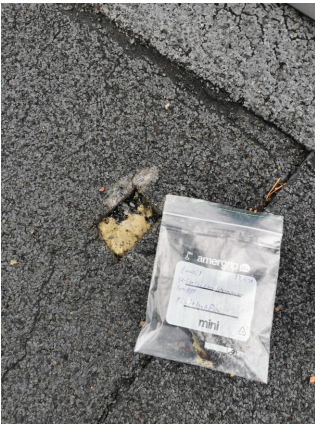
Kuva rakennuksen katon näytteen otosta.
