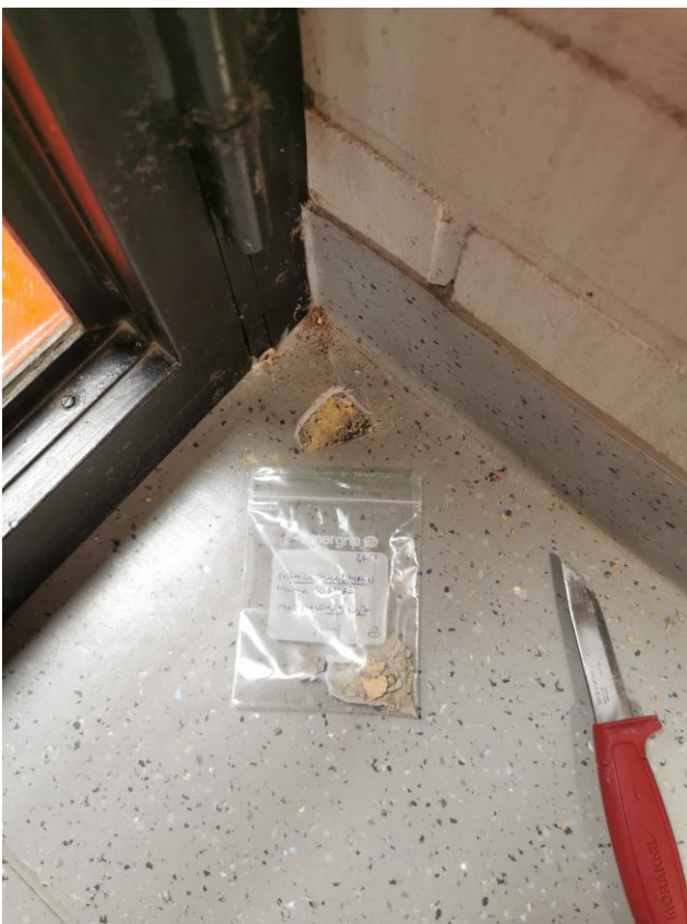
Kuva käytävän lattian näytteen otosta.
