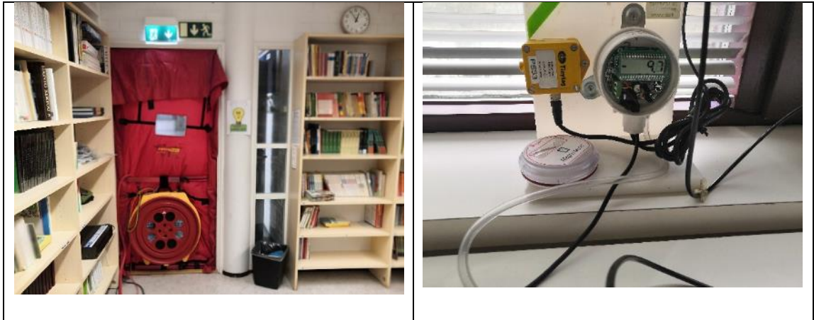
Kuva 5.40. Tilat alipaineistettiin n. -10 Pa, merkkiainetutkimusten ajaksi.
