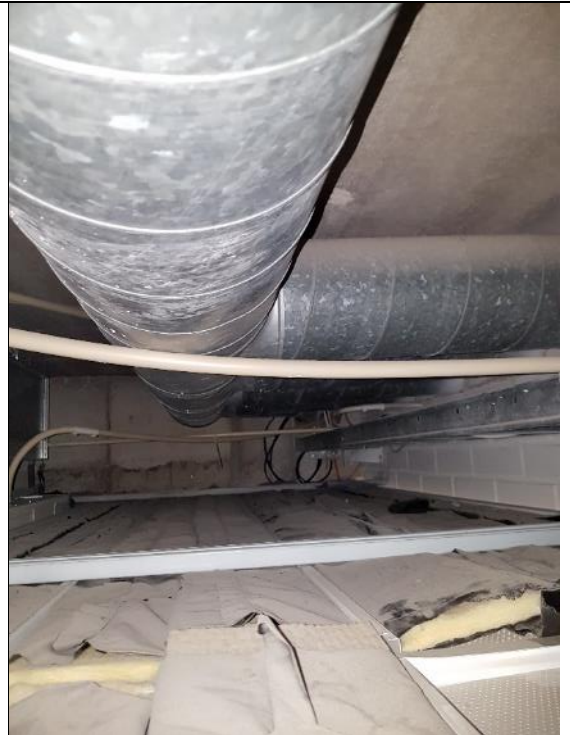
Kuva 5.73. Alakattojen päällä on erittäin runsaasti pölyä ja kuitulähteitä äänenvaimennuspusseissa.
