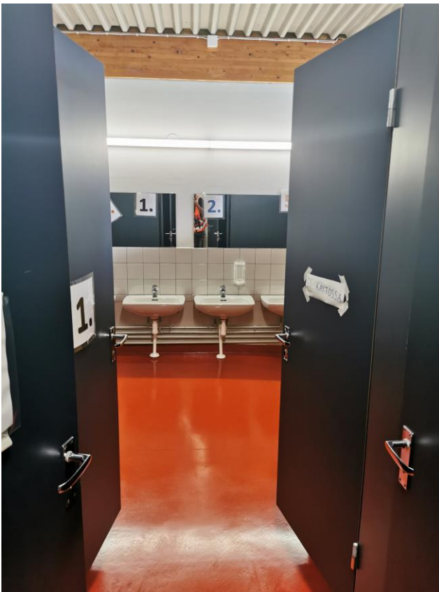
Yleiskuva kohteen alkuperäisestä wc tilasta.
