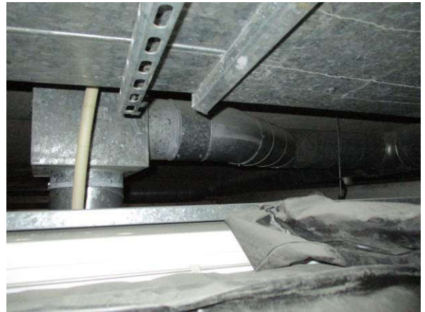
Ilmanvaihtokanavointia alas lasketun katon suojassa
