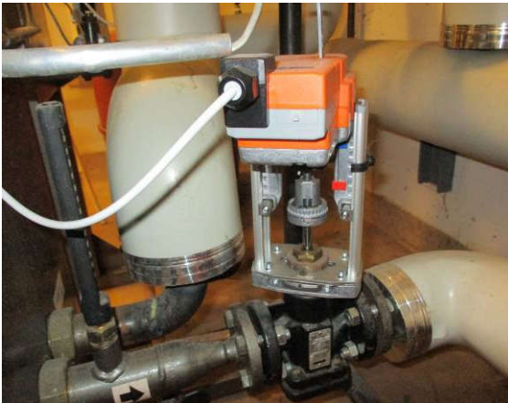
Lämmönjakokeskuksen toimilaitteita on uusittu
