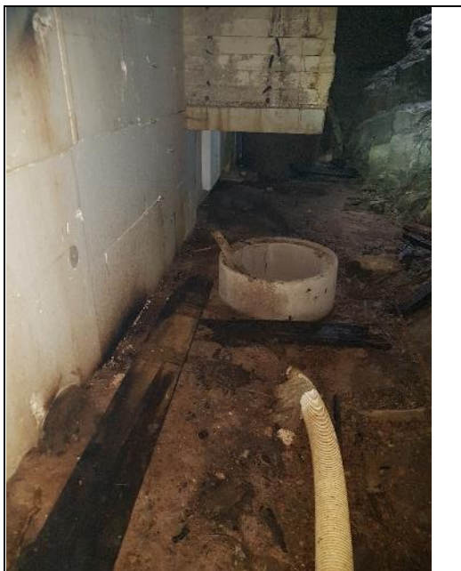
Kuva 5.80. Salaojat kulkevat maanpinnan yläpuolella. Maa on märkää salaojien ympärillä, mutta salaojissa ei virtaa vesi.
