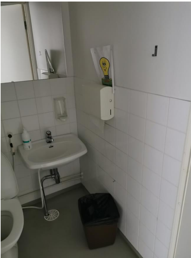
Yleiskuva kohteen wc:n laatoituksista.
