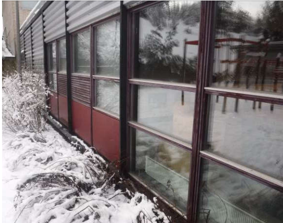
Alkuperäistä ikkunaa; osassa ikkunoita on teräspuitteet
