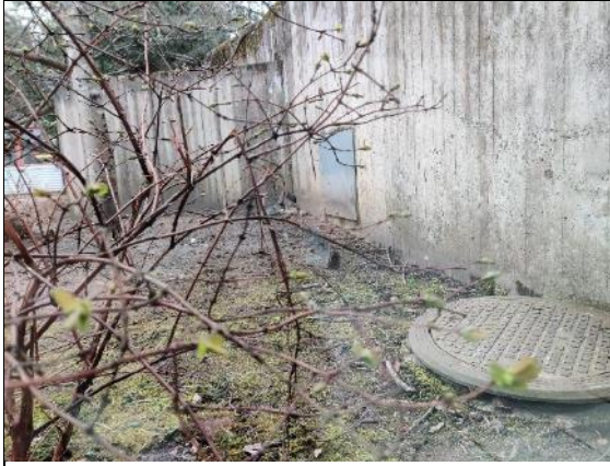
Kuva 5.5 Itäsivun tukimuurissa on luukku, josta pääsee liikuntasalin ympärillä olevaan louhituun sulkutilaan.
