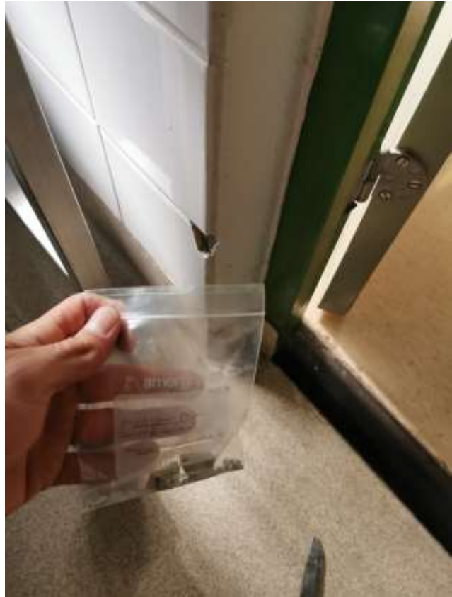
Kuva keittiön seinän näytteenotosta.
