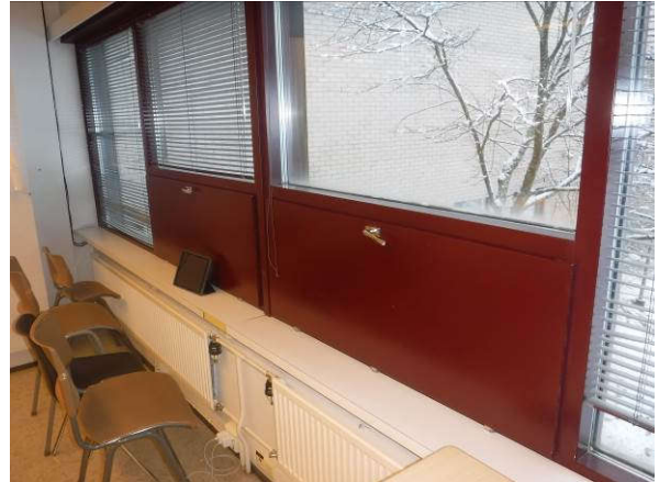
Ikkunaa, jossa on tuuletusluukut
