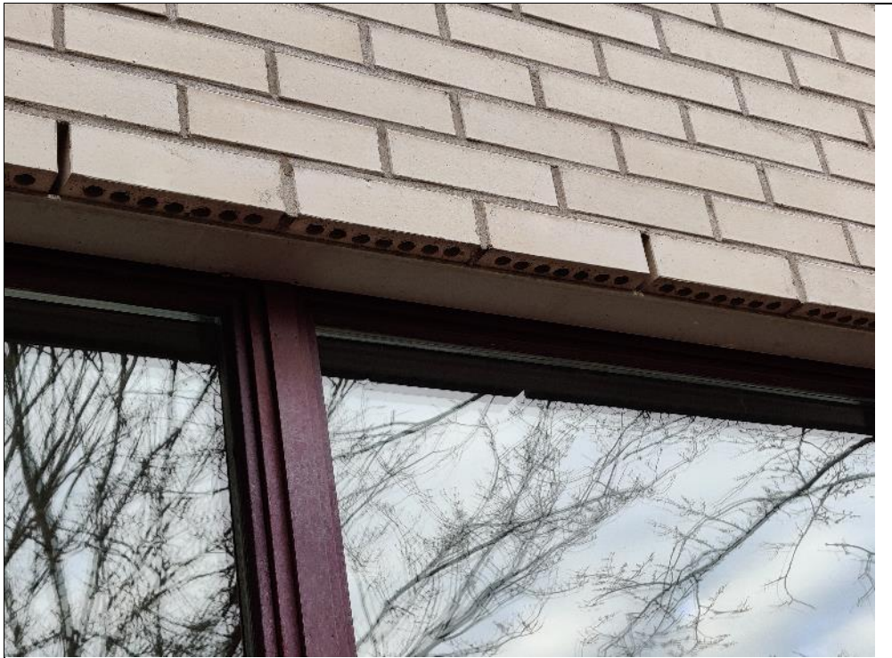
Kuva 5.1. Liikuntasalin julkisivuissa on tuuletusraot.
