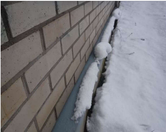
Liikuntahallin sokkeliä ylärinteen puolella; sokkelin yläpinnassa suojapelti
