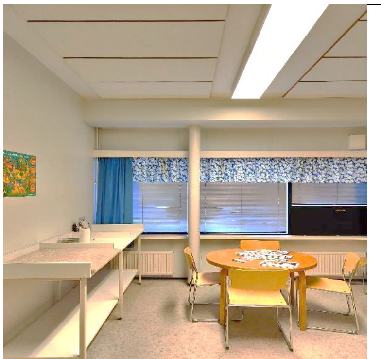
Kuva 5.75. Terveydenhoitajan tilojen katossa on reunoiltaan pinnoittamattomia akustiikkalevyjä.
