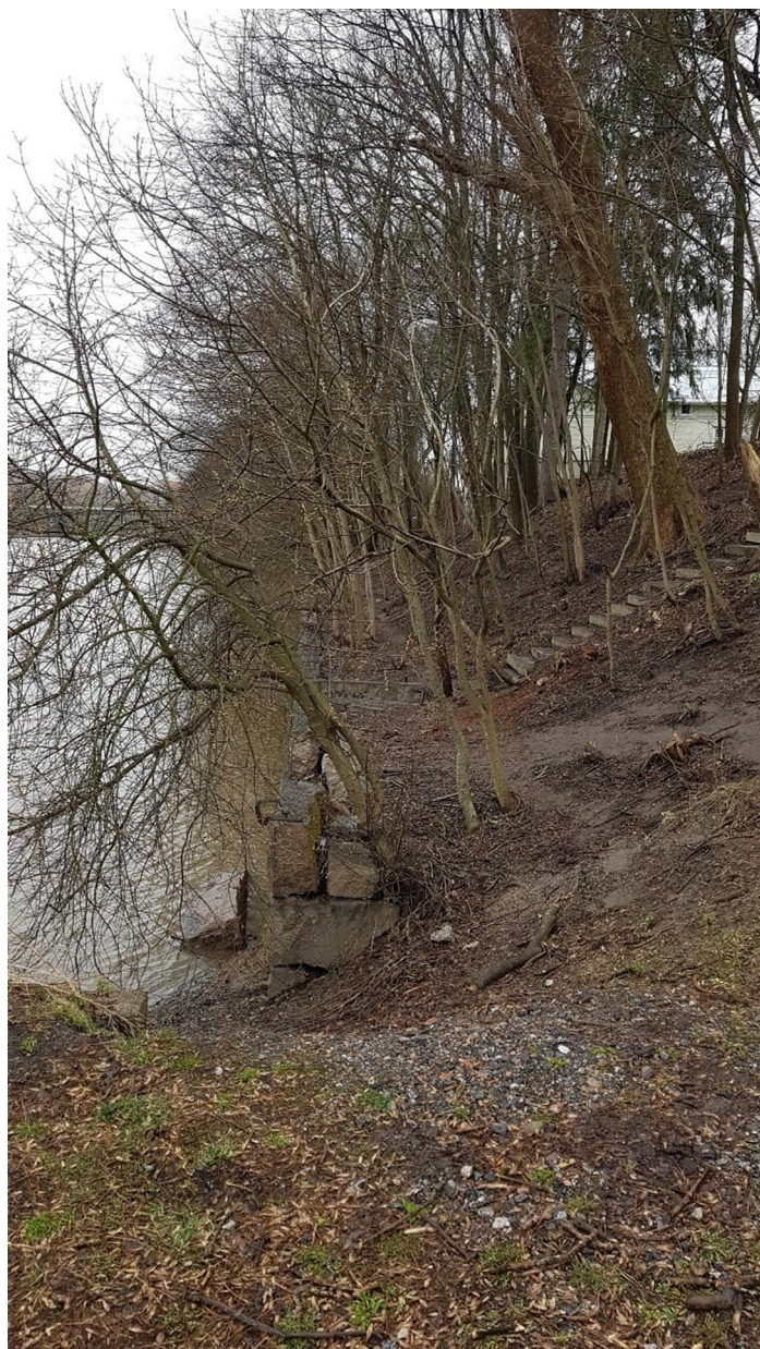
Vanha rantamuri kuvattuna joen itärannalta, Agricolankadun kohdalta.
