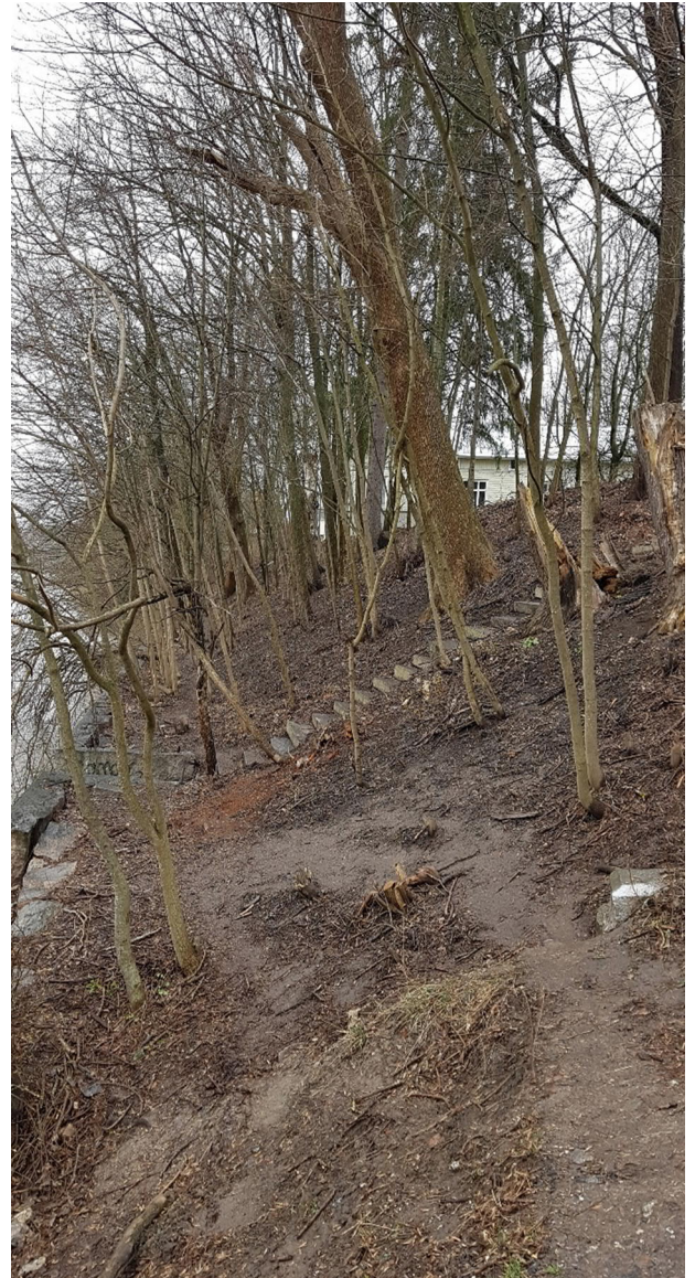
Kuva Piispantalon kohdalta. Kuvassa vanhaa tukimuuria ja vanhat portaat.
