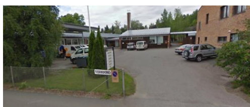
Vähäheikkiläntie 37 sisäpihan rakennuksia
