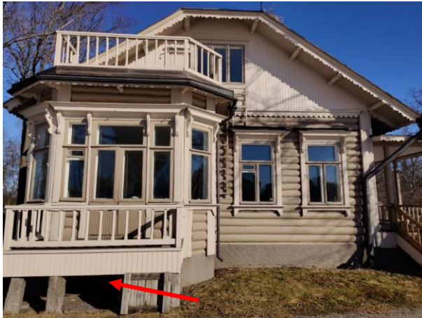
Kuva 19. Ryömintätilaan on kulku rakennuksen eteläpäädyssä.
