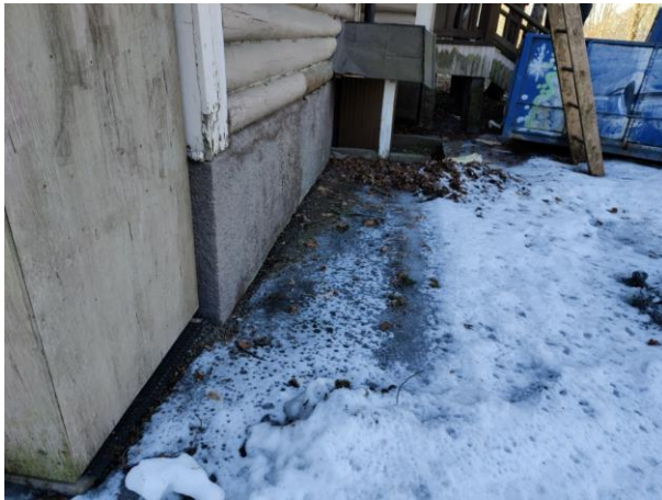
Kuva 3. Maanpinnan kallistukset ovat tasaisia tai kallistavat rakennusta kohti vierustoilla.
