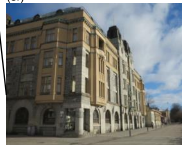
Kiinteistö Oy Turun jugendlinna, 1909 ent. kaupunginkanslia arkkitehtitoimisto K.Wasastjerna ja G. A. Lindberg (sr)
