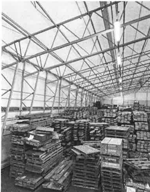
Kuvat 7 ja 8: Pilarit ovat suorassa linjassa eikä taipumia havaittu. Pinnat ovat likaiset mutta ruostetta ei liitoksissa havaittu kuin satunnaisia pieniä, yksittäisiä kohtia.
