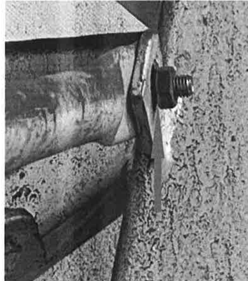
Kuva 2: Vinositeen kiinnityksessä rako hallin vasemman nurkan alaosassa.
