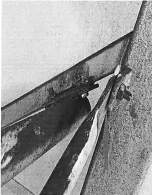
Kuvat 9 ja 10: Rako vinositeen liitoksessa ja mutteri löysässä, hallin vasemman nurkan yläosassa. Hitsisaumat ovat hyväkuntoisia.
