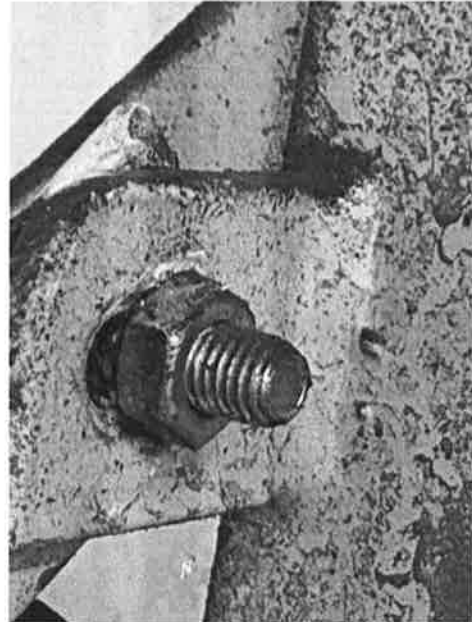
Kuvat 9 ja 10: Rako vinositeen liitoksessa ja mutteri löysässä, hallin vasemman nurkan yläosassa. Hitsisaumat ovat hyväkuntoisia.
