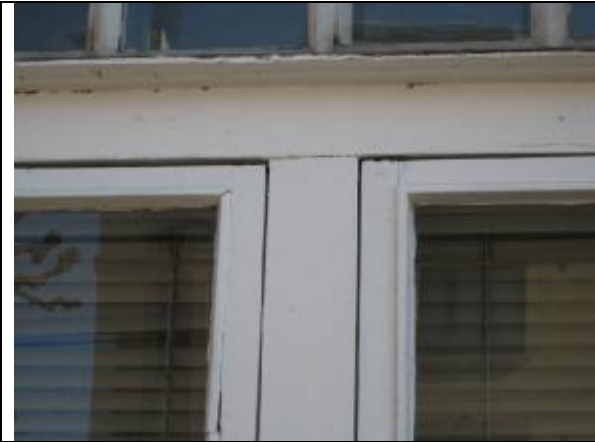
27. Ikkunoiden käyntivälit ovat suurehkoja
