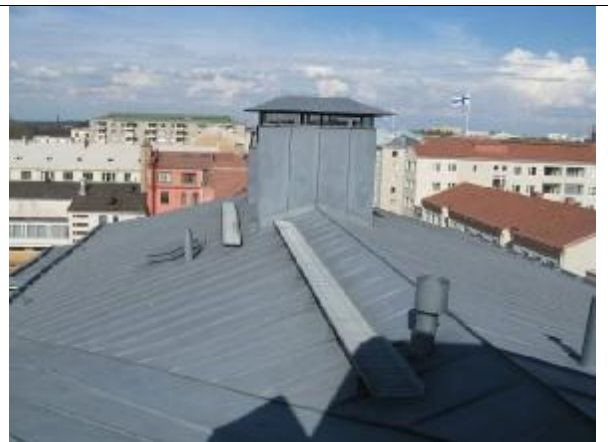
46. Koillissiiven vesikatto, vasemmalla kattoluukku koillissiiven yläpohjatilaan, yläpohjatilaan on päästävissä myös ullakolla olevan huoltoluukun kautta
