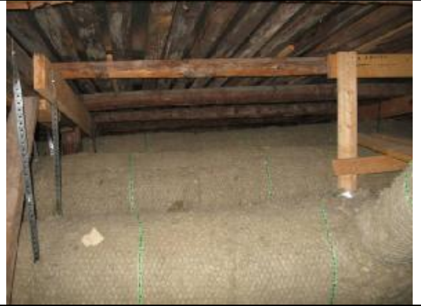
42. Koillissiiven yläpohjatilaa, eristettyjä ilmanvaihtokanavia
