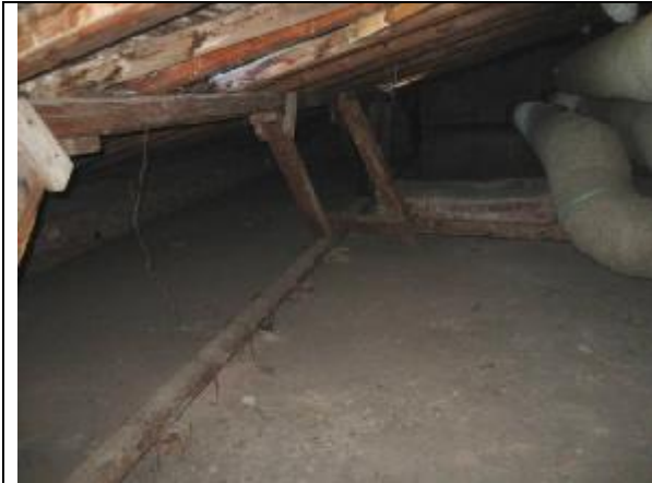
43. Luoteisosan (laajennusosa) yläpohjatilaa ja vesikattorakenteita, eristettyjä ilmanvaihtokanavia oikealla
