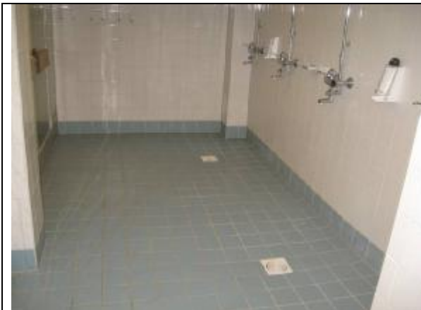
65. Koillispuolella olevan voimistelusalin pukuhuoneen suihkutila
