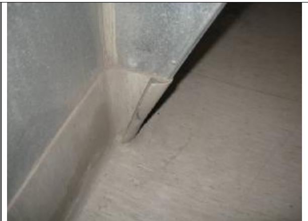
84. Kammion muovimaton noston sauma on auennut
