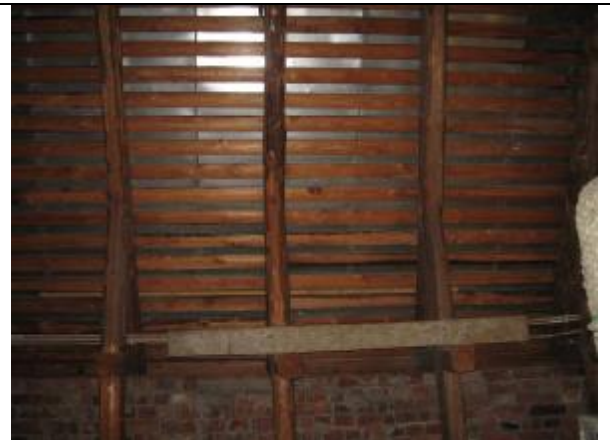
40. Peltikatteen alusrakenteena on harvalaudoitus, kosteutta saattaa tiivistyä määrättyissä sääolosuhteissa peltikatteeseen alapintaan. Ullakon hyvä tuulettuminen on tärkeää, jotta rakenteet kuivuvat nopeasti säätilan muuttuessa.
