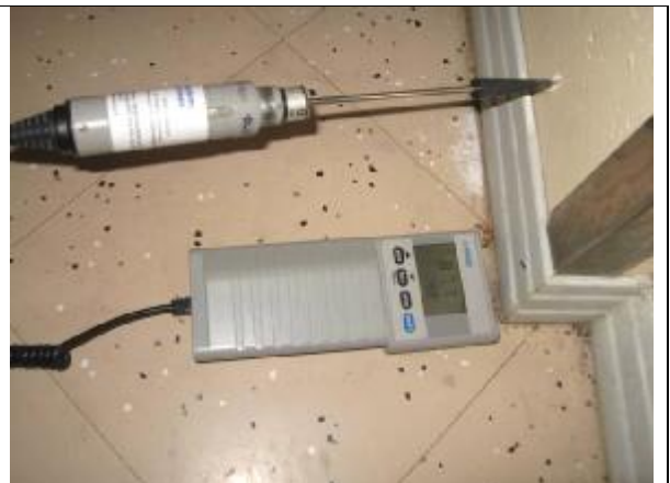
70. Kosteusmittaus ruokailutilan puukoolatun seinän alaosasta
