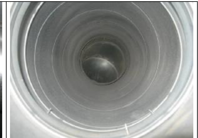
90. Ilmanvaihtokanava, sisältä kuvattuna, ei epäpuhtauksia
