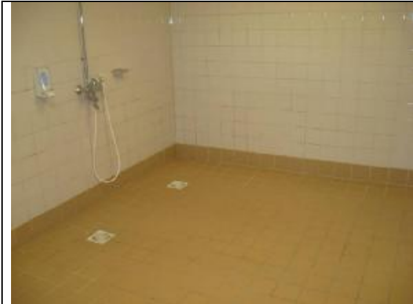
67. Luoteispäädyn voimistelusalin pukuhuoneen suihkutila, laattasaumoissa tummummaa
