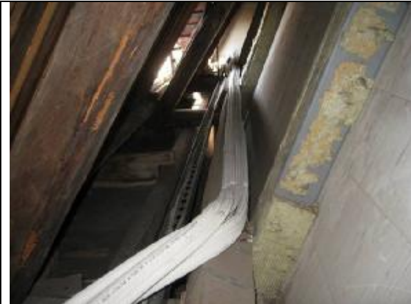
37. Vesikaton jyrkän lappeen ja ilmastointikonehuoneen seinän välinen sivuontelo
