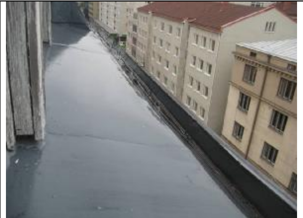
48. Maariankadun puoleinen jalkokouru ja 4.kerroksen luokkahuoneen ikkunan eduspellitys
