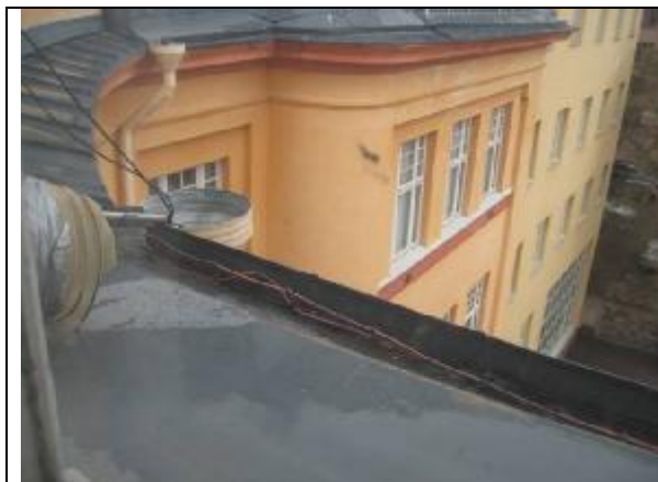
49. Pihanpuoleisia jalkokouruja ja syöksytörvien yläpäiden suppiloita
