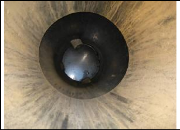
96. Perusvesikaivo, rakennuksen itänurkassa
