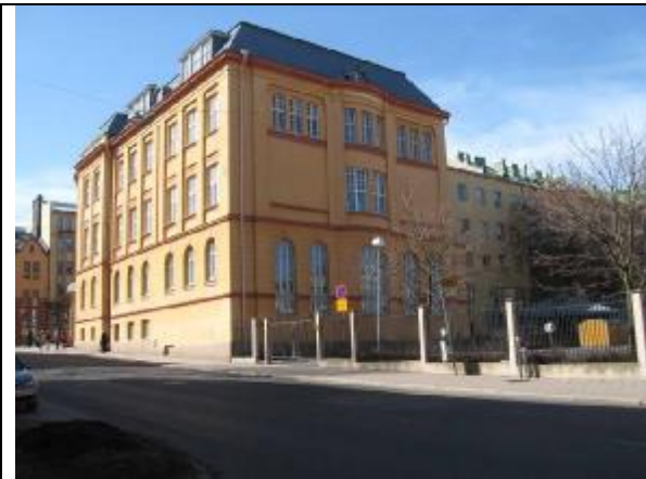
3. Maariankadun puoleinen julkisivu ja koillispääty
