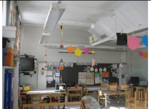
60. Luokkahuoneen tyypillinen kattomuoto, käytävän puoleinen katon osa on alaslaskettu
