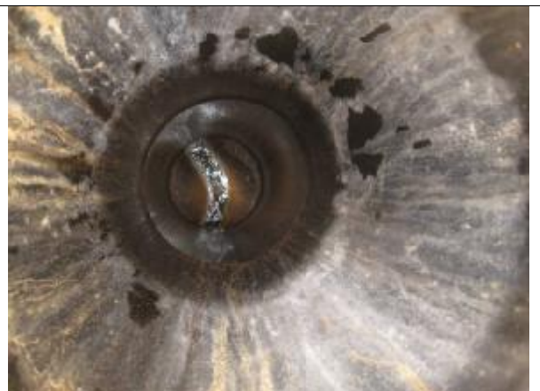
94. Viemäriin tarkastusputki/kaivo, viemäriin suunnan muutos
