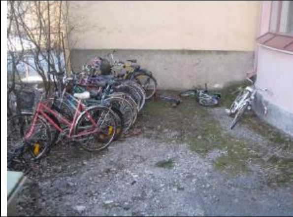
15. Naapurikiinteistön (Aurakatu 15) pihan maanpinta viettää tarkasteltavaa rakennusta kohti. Pintavesille ei ole erityistä ohjausta.
