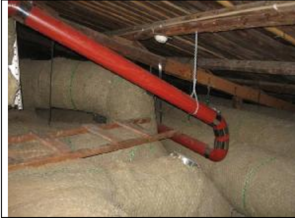
41. Koillissiiven yläpohjatilaa, eristettyjä ilmanvaihtokanavia, viemärin tuuletusputki
