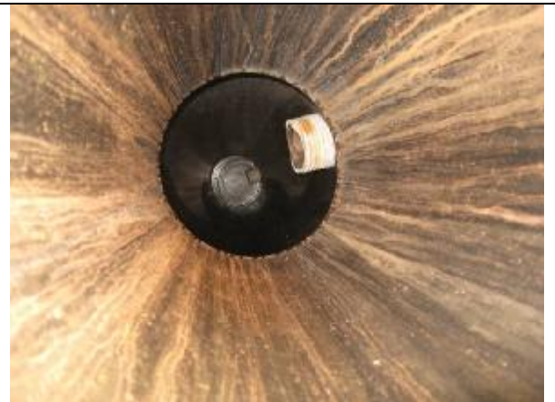
10. Salaojan tarkastuskaivo, ylin kaivo Aurakadun puolella. huomaa kaksi päällekkäistä salaojaputkea
