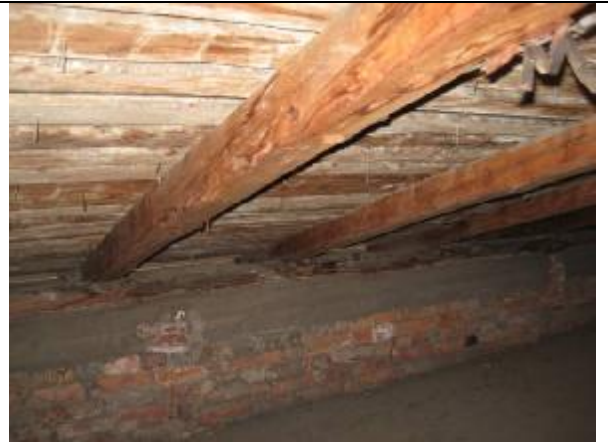
44. Luoteisosan (laajennusosa) vesikattorakenteita; Räystään alla on tuuletusraot tällä osalla.
