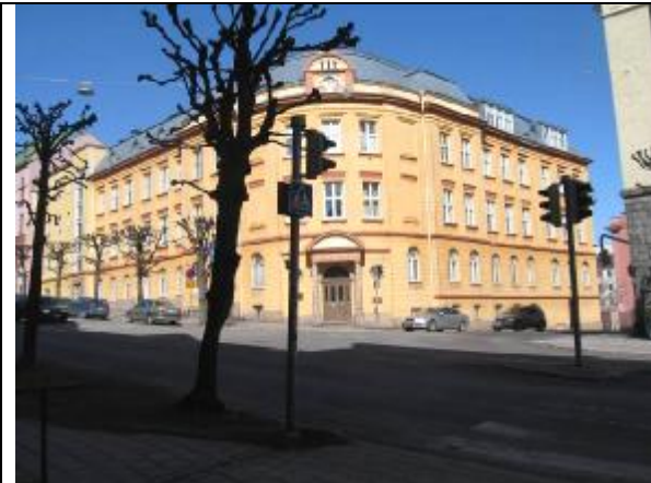
1. Kadun puoleiset julkisivut
