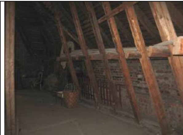
39. Korkea ullakko, vesikaton puurakenteita (kontti- ja kappeläpuut)
