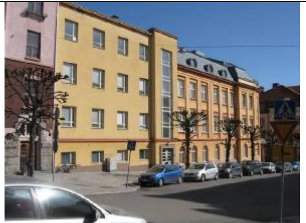
2. Aurakadun puoleinen julkisivu, laajennusosa vasemmalla
