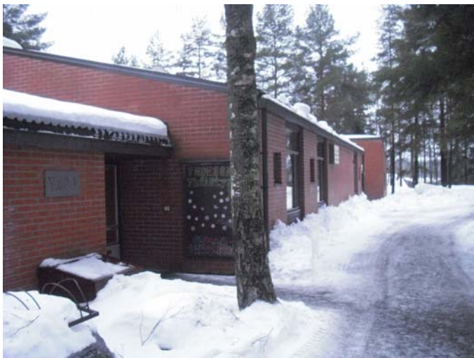
Kuva 1 Rakennusta pohjoiseen – ylärinteeseen
