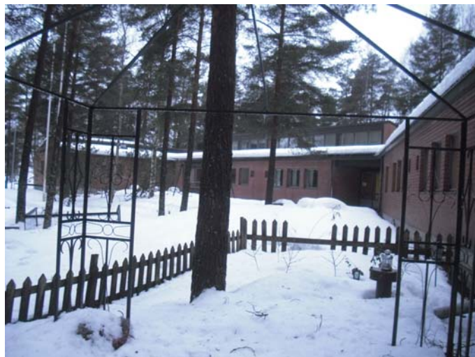
Kuva 2 Rakennusta etelään - alarinne
