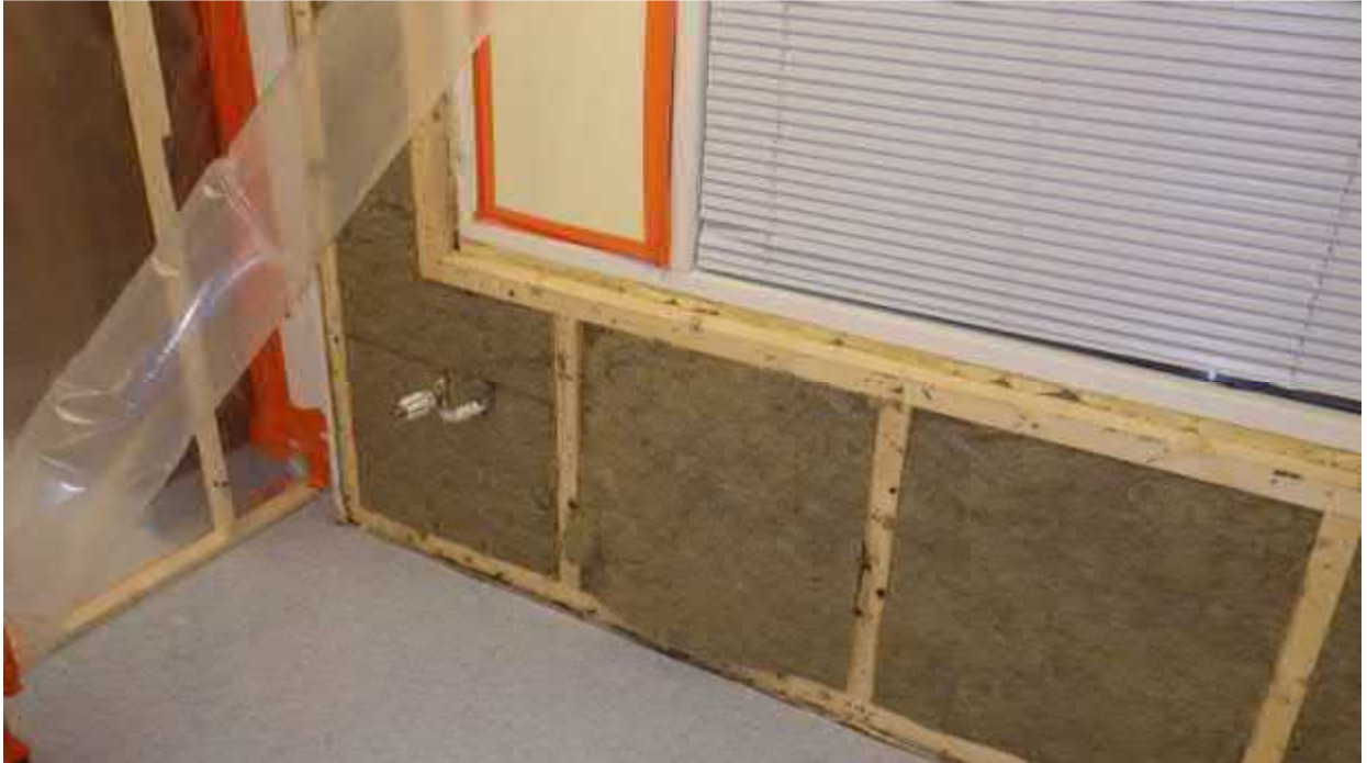
Kuva 22. Seinärakenteen avaus sisäpihan puolella sijaitsevaan perhetuvan ryhmätilaan.
