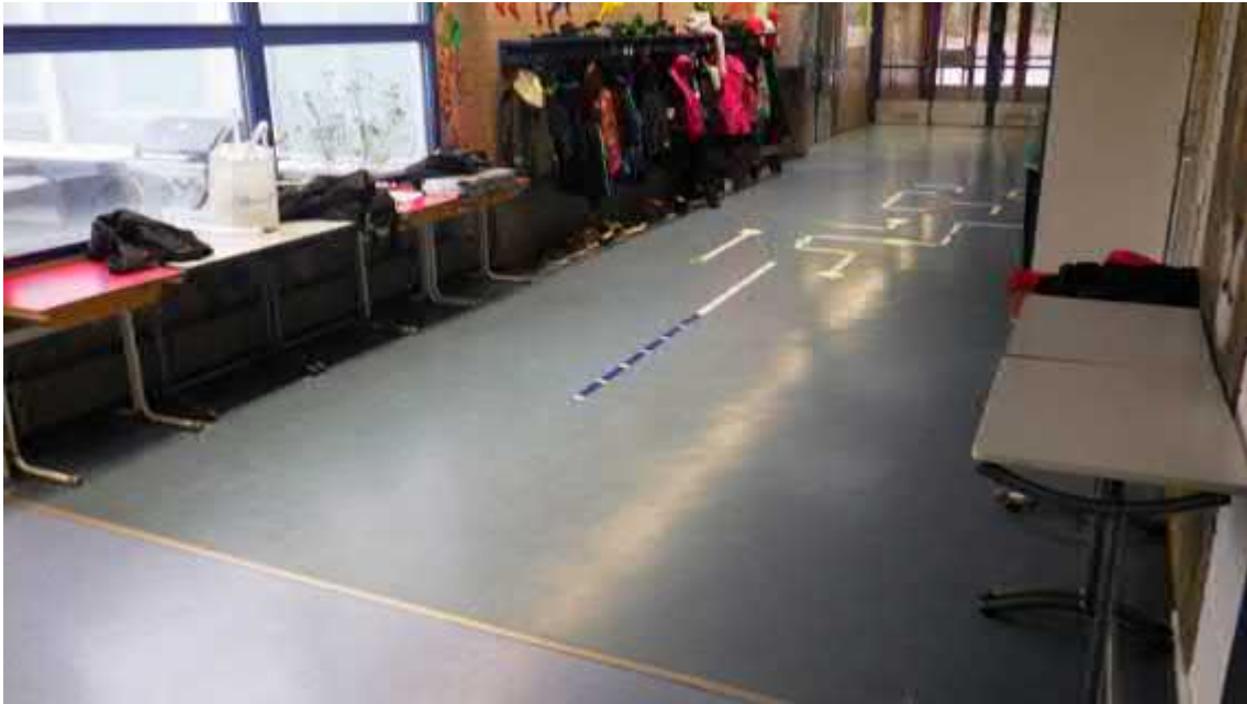
Kuva 10. Vanhaa muovimattoa ja uusittua muovimattoa.
