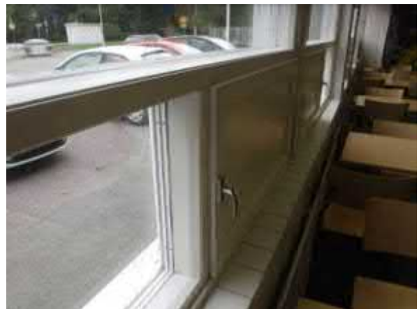
Ikkunat ovat kokonaisuutena tyydyttävässä kunnossa
