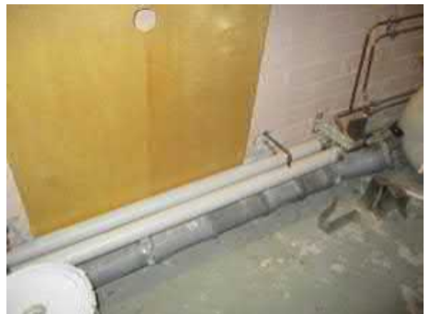
Uusittuja vesijohtoja
