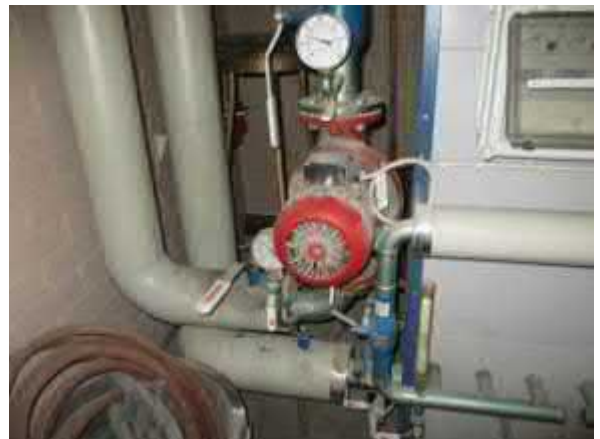
Lämmityksen kiertovesipumppu
