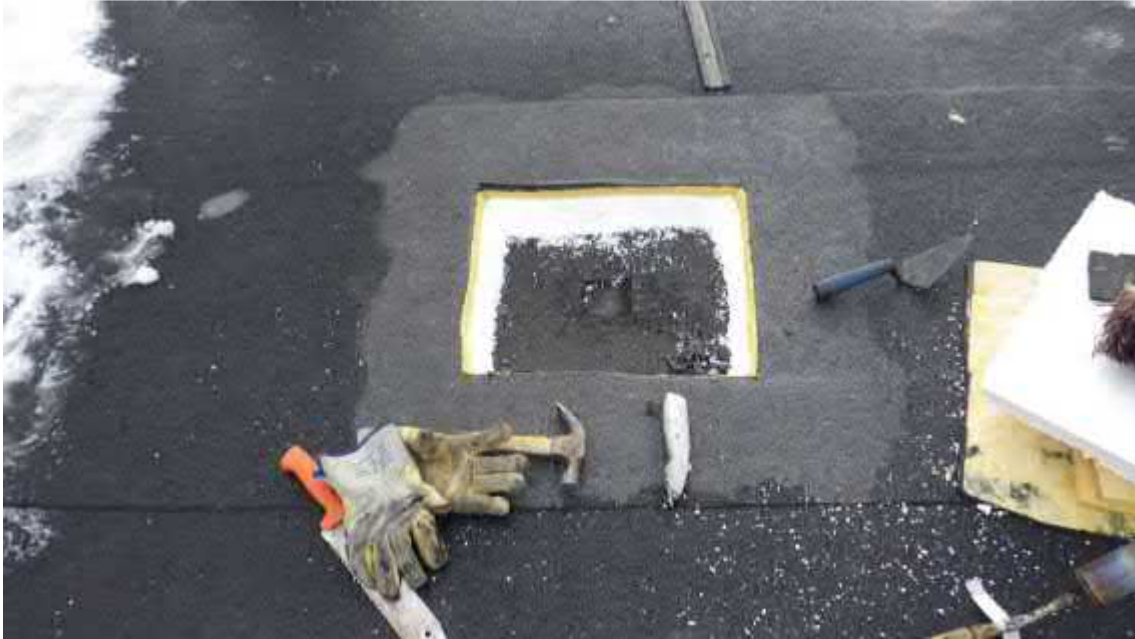
Kuva 16. Vesikaton rakenneavaus.
