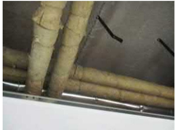
Vesijohtoja alas lasketun käytäväkaton suojassa
