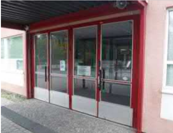
Ulko-ovia, jotka on sääsuojassa katoksen alla
