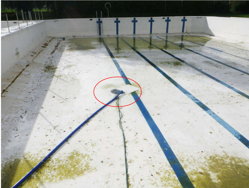
Kuva 5. ...kuten pienemmässäkin (syvässä) altaassa. Tutkimushetkellä veden tuotto kai- von kautta oli huomattava, sitä poistettiin uppupumpulla
