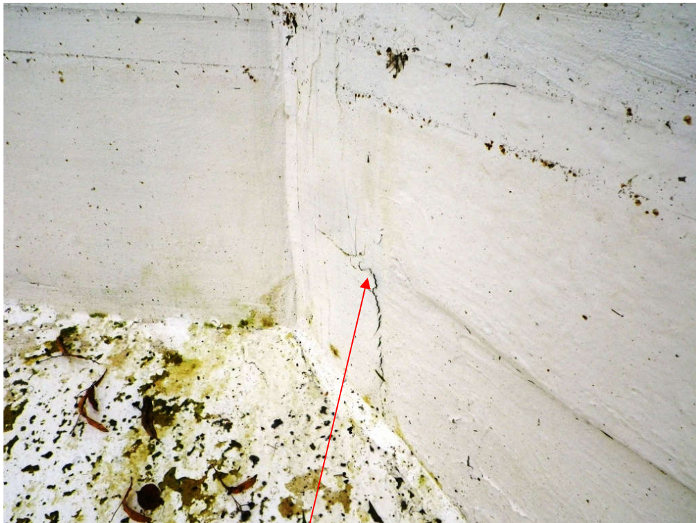
Kuva 6. Halkeamia betonivaluissa...
