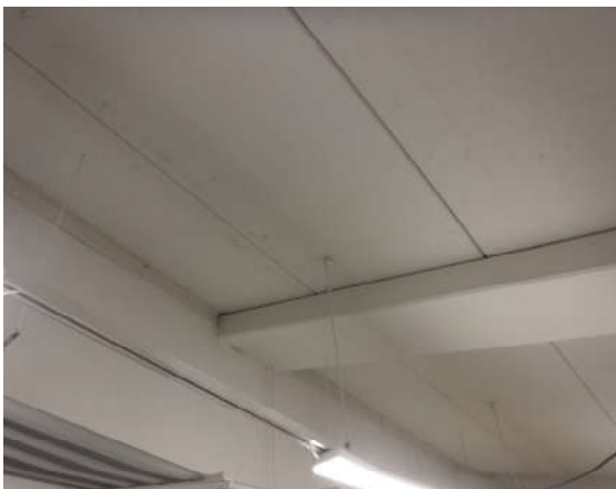
Katsomon tukirakenteita sisätilasta tarkastellen
