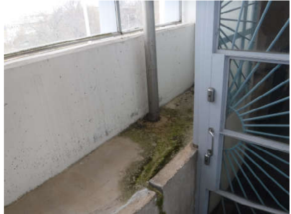
Leväkasvustoa betonipinnalla
