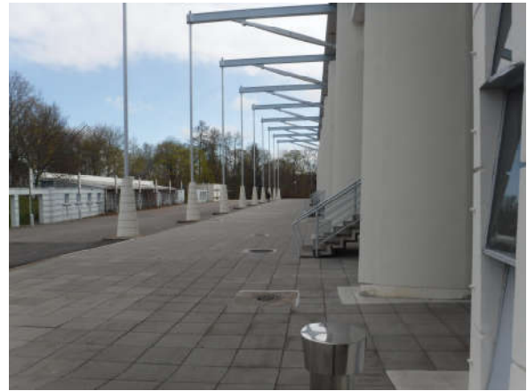
Etupihan julkisivua ja betonilaatoitusta
