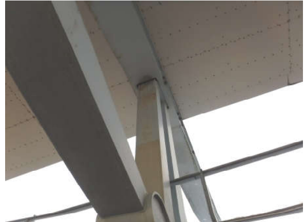
Teräs- ja betonirunkoa, jotka toimivat yhdessä
