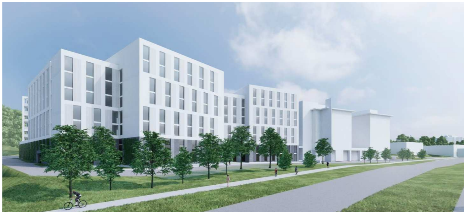
©TURUN KAUPUNKI (BM-ARCHITECTS)
