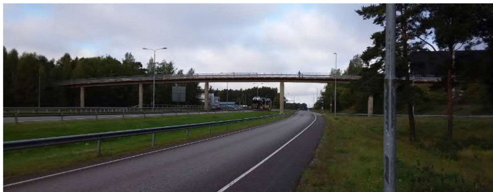
Kuva 5: T-4235 Tolpontien ylikulkukäytävä (Tampereen valtatie)
