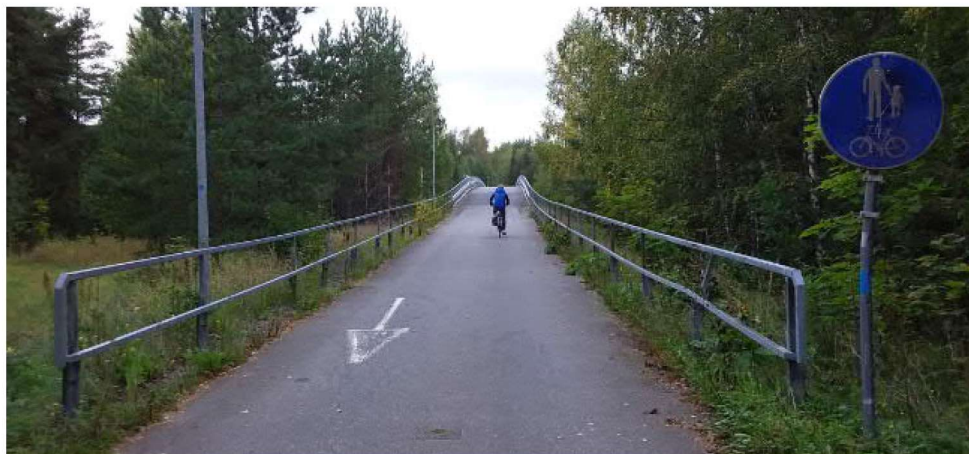
Kuva 6: T-4235 Tolpontien ylikulkukäytävä (Tampereen valtatie)
