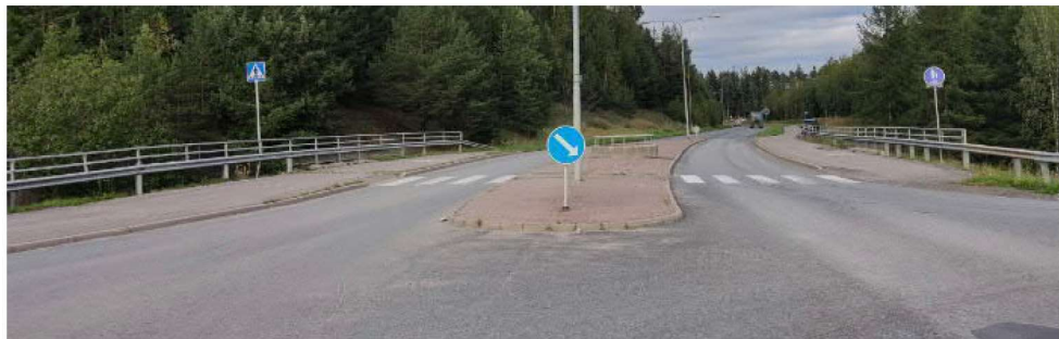
Kuva 4: T-4147 Topinojan alikulkukäytävä
