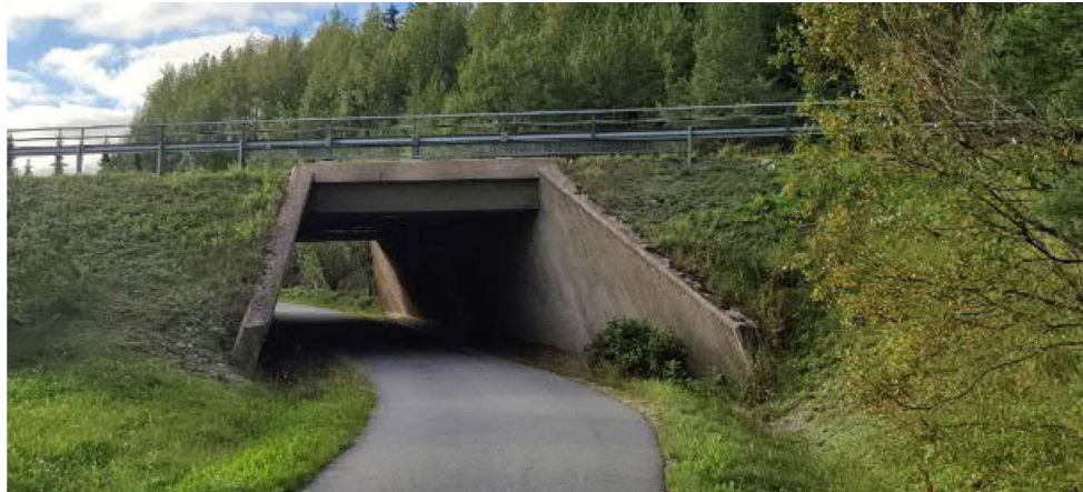
Kuva 3: T-4147 Topinojan alikulkukäytävä
