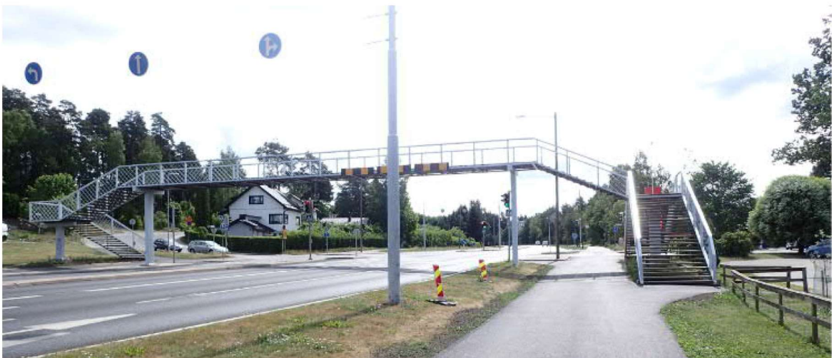
Kuva 4: T-4212 Littoistentien jalankulkusilta [TREX 2019]
