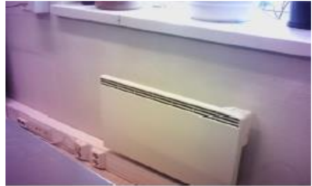
Kuva 59. Patterin pintalämpötila 86,7 °C.
