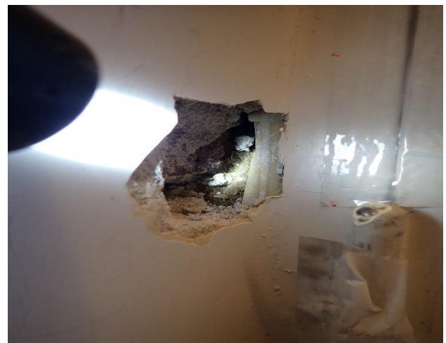
Kuva 24. Tilkkeenä pellavarivettä.
