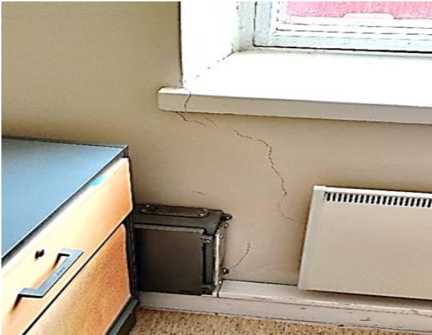
Kuva 17. Halkeamia ulkoseinässä.
