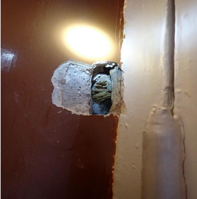
Kuva 21. Ikkunakarmin kiinnityspuu.
