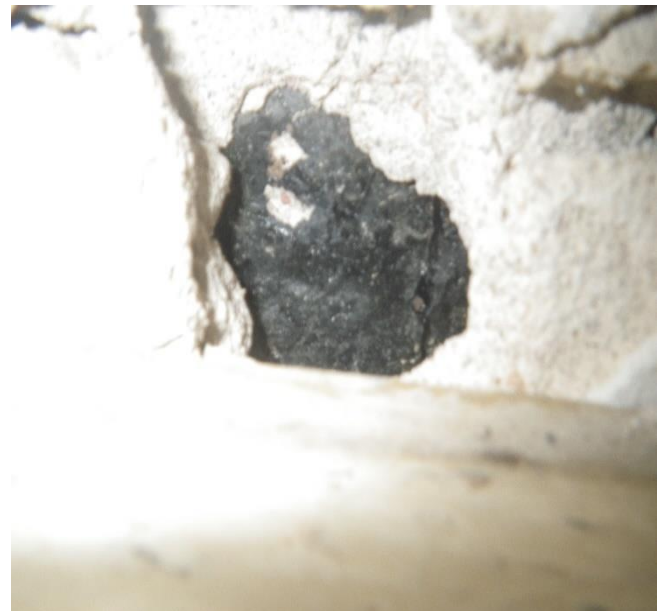
Kuva 54. Bitumisivelyä rappauksen alla, tila 245.
