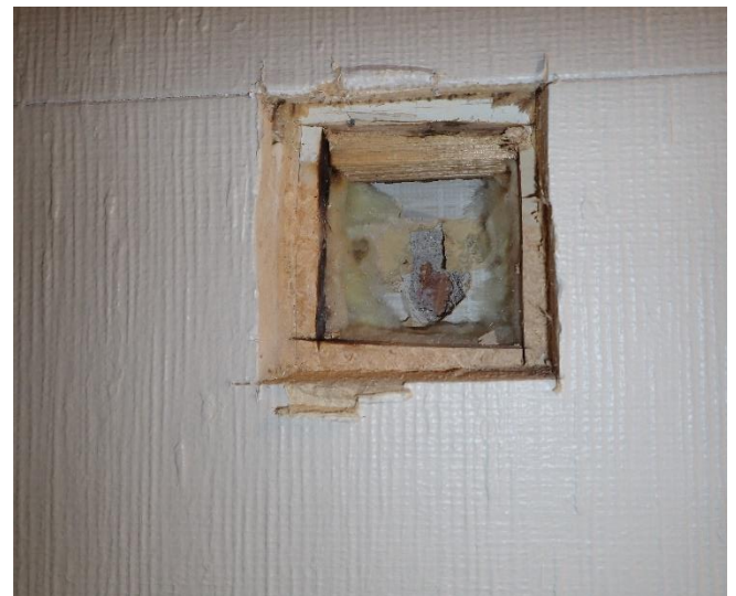
Kuva 16. Rakenneavaus lisäeristettyyn seinään.
