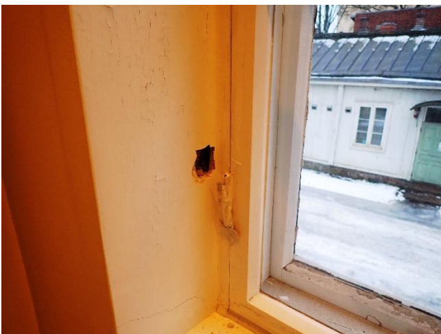
Kuva 23. Rakenneavaus ikkunarakenteeseen tilassa 237.
