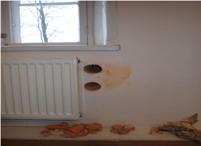
Kuva 23. Rakenneavaus ulkoseinään tilassa 232.
