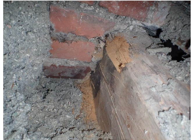
Kuva 58. Rakenneavausten yhteydessä havaittu lahovaurio yläpohjapalkissa.
