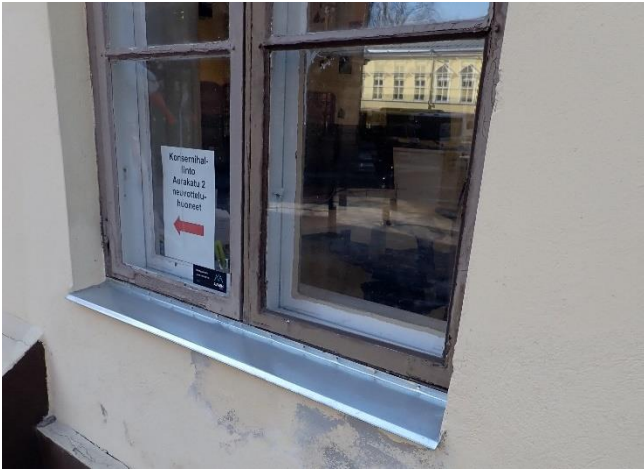
Kuva 33. Uusittu ikkunapelti.
