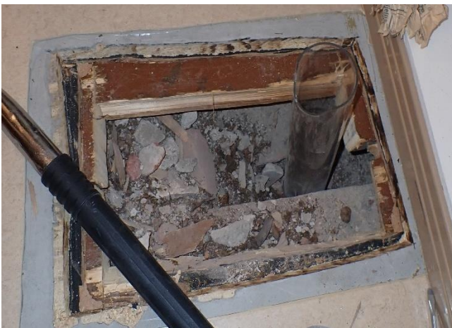
Kuva 47. Tila 230 Välipohjatäyttöä tilan 230 rakenneavauksessa.
