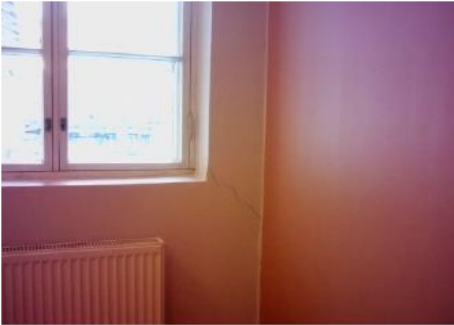
Kuva 26. Halkeamia ulkoseinässä.
