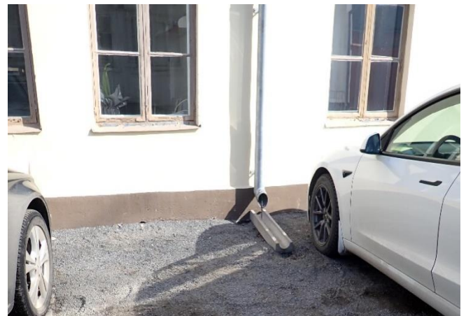
Kuva 5. Sadevesien ohjausta takapihalle.
