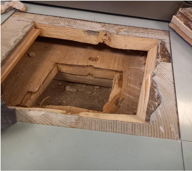
Kuva 18. Rakenneavauksessa näkyy vanha lattiamatto (lino-leum) uudemman ponttilautaan liimatun vinyylilaatan alla.
