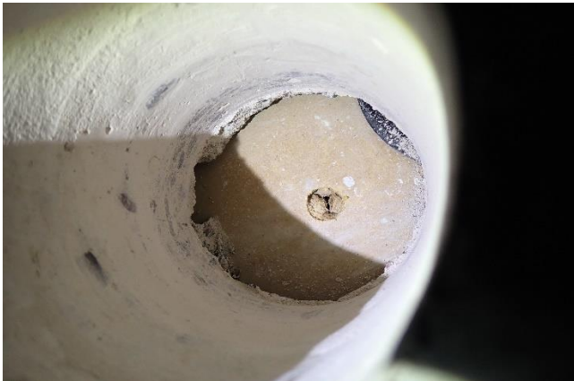
Kuva 16. Kovalevy betonilaatan alla (AP5).
