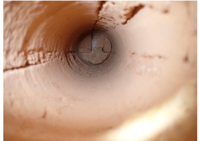
Kuva 24. Rakenneavaus ulkoseinään tilassa 232, poraus-syvyys 400 mm.
