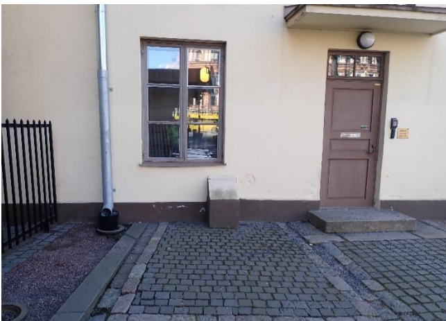
Kuva 4. Sadevesien ohjausta etupihalla.
