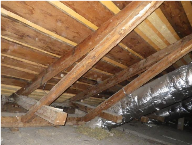
Kuva 50. Ruodelaudoitusta on paikoin uusittu.
