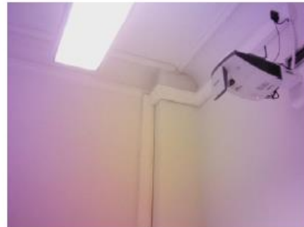
Kuva 49. Ilmavuotoa koillispäädyn kylmästä hormista, tilassa 205. Ote lämpökuvausraportista liite 2
