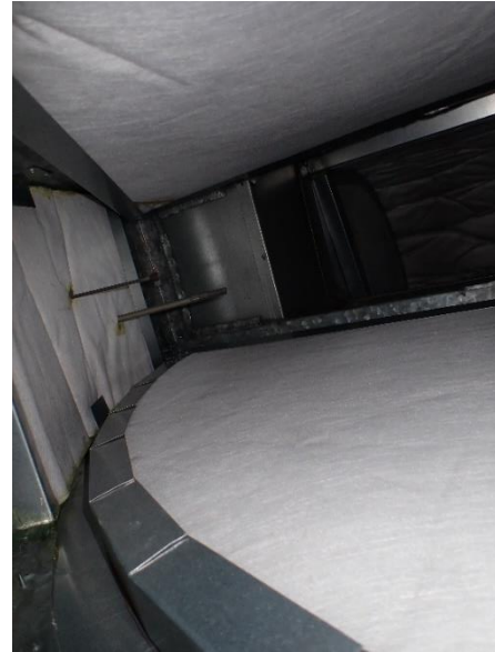
Kuva 58. Tuloilmakammion äänenvaimentimet ovat puhtaita ja kuituvapaata materiaalia.
