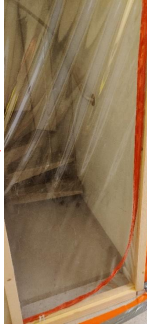
Kuva 45. Porrashuoneen 010 kierreportaat ovat avoimet, eikä niiden alla ole umpinaista tilaa. Kellarikerros on erotettu ensimmäisestä kerroksestä muoviseinällä.
