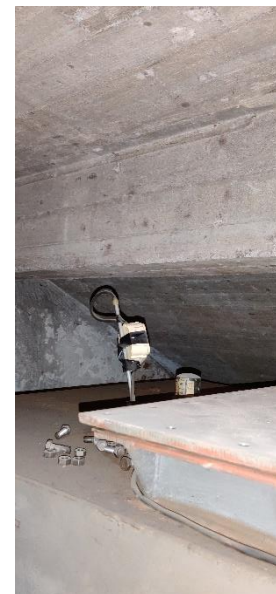
Kuva 46. Porrashuoneen 112 alla on käytöstä poistettu öljysäiliö. Portaiden alla ei ole muottilautaa.
