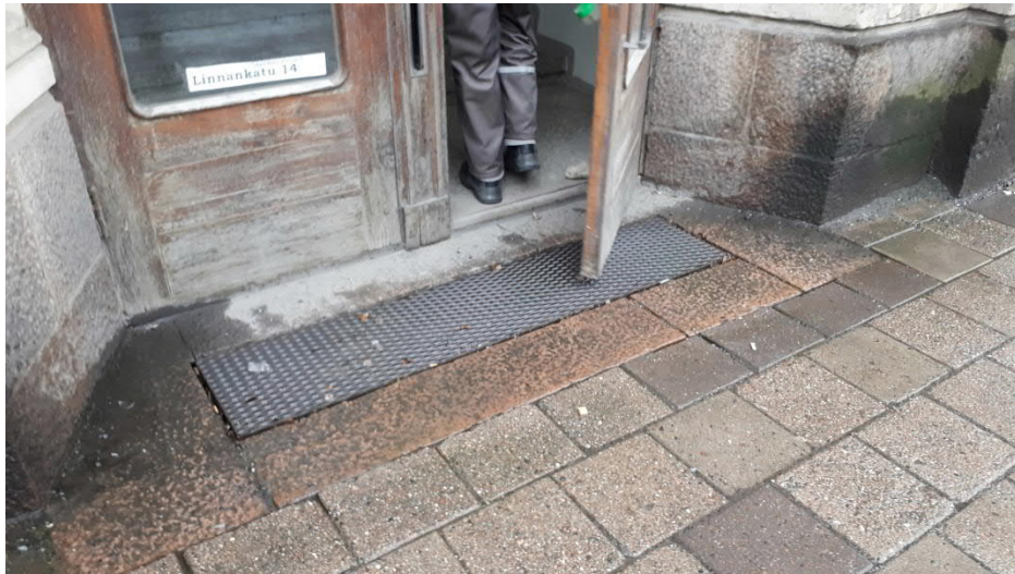
Kuva 9. Rakennuksen sisäänkäynti Linnankadun puolella on aivan kadun tasossa.
