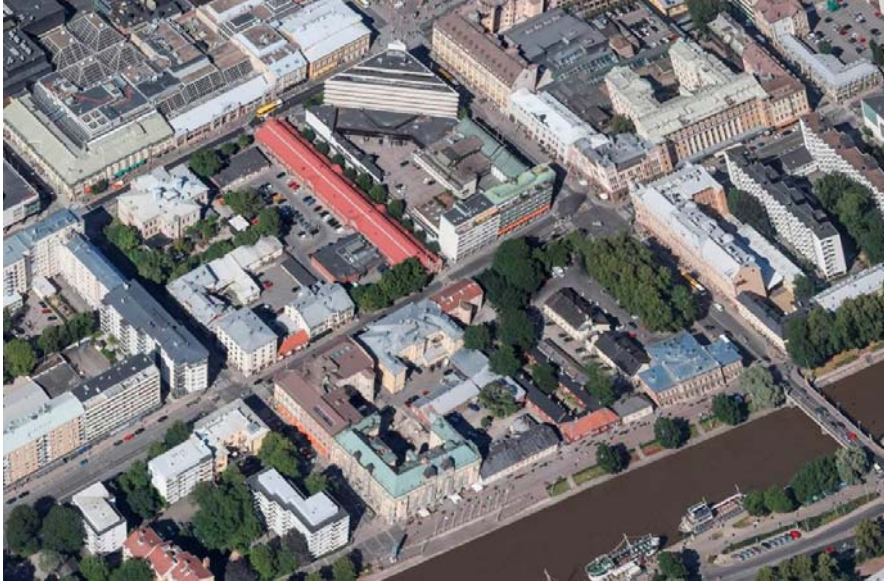
Kuva 16 Ilmakuva kaupungintalon ja kauppahallin kortteli
