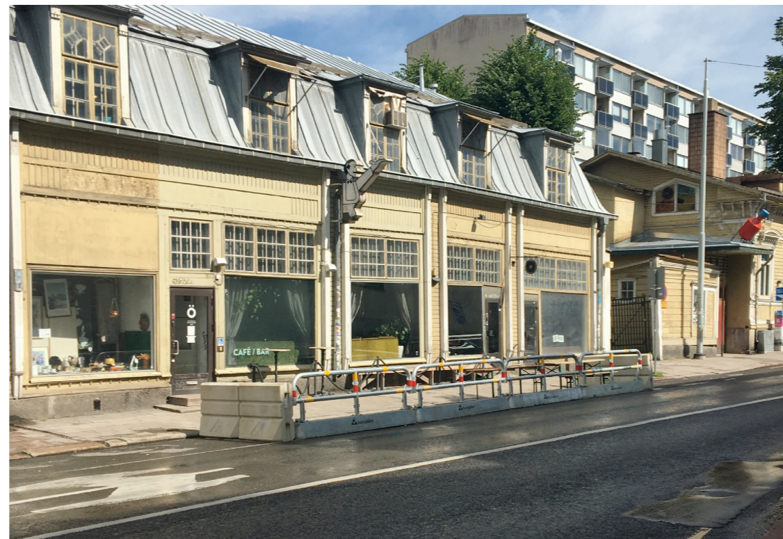
Valokuva terrasin suojarakenteista.
