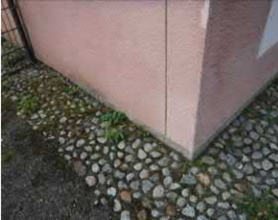
Sokkeli on paikoin hyvin matala
