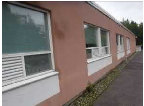
Sokkelia ja ulkoseinää pitkällä sivulla
