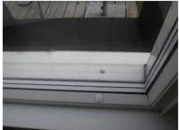
Kiinteä ikkuna, jossa on kaksi lämpölasielementtiä
