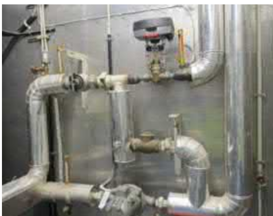
Toimilaitteet ovat pääosin varsin hyväkuntoisia
