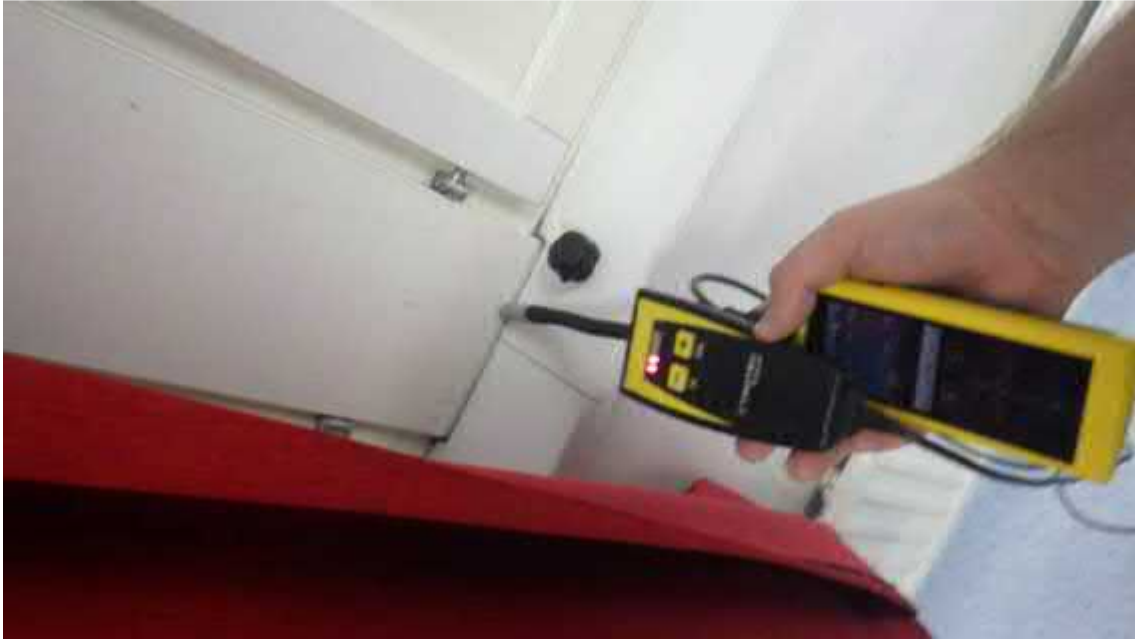
Kuva 14. Vuoto ikkunoiden välisessä liittymässä.
