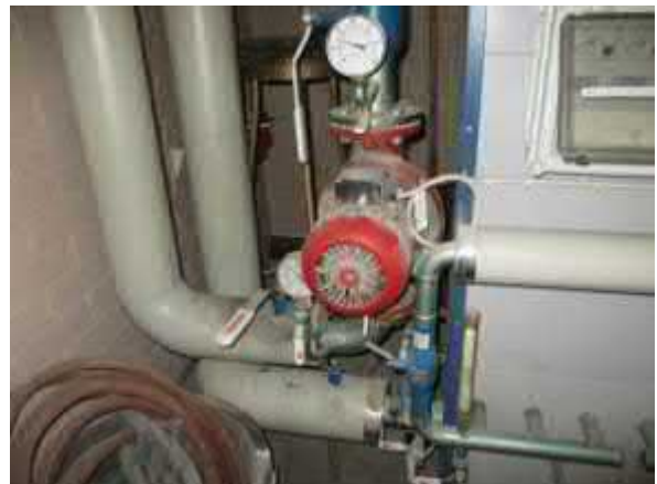
Lämmityksen kiertovesipumppu
