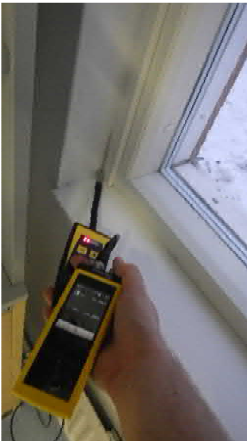
Kuva 15. Vuoto smyygi liittymässä.
