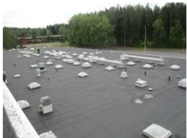
Vesikatolla on runsaasti huippuimureita
