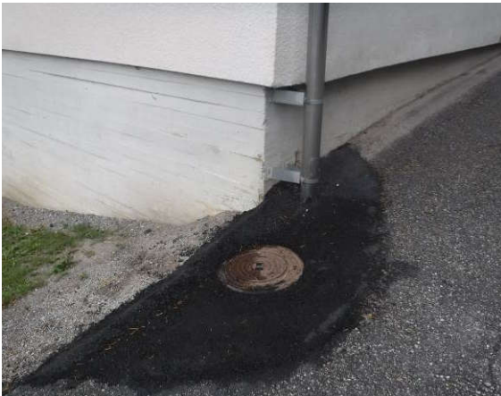
Kattovedet on ohjattu omaan poistojärjestelmään
