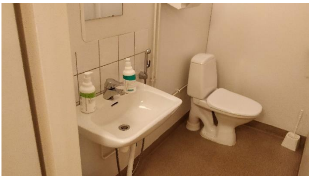
Kuva 9. B-siiven alkuperäiset seinälaatoitukset eivät sisällä asbestia.
