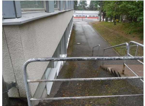
Ulkoportaati ja niiden yhteydessä olevat teräskaitteet
