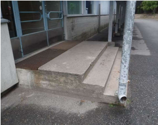
Betoniportaati ja -taso oven edessä
