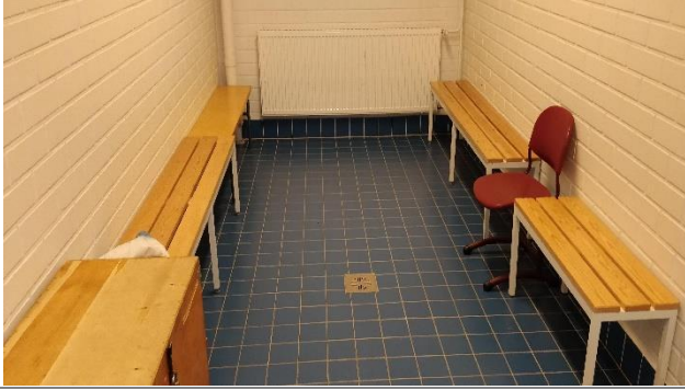
Kuva 17. Pesu-, puku- ja wc-tiloissa havaittiin uusittuja laatoituksia. Laatoituksia ei avattu.
