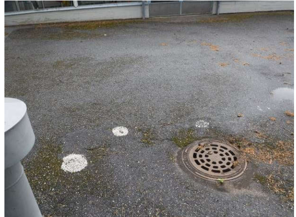
Pintavedet on ohjattu pääosin sadevesikaivoihin
