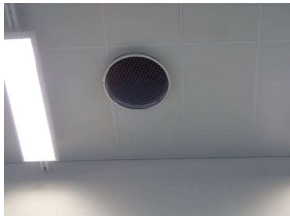
Poistoilmaventtiili liikuntasalissa
