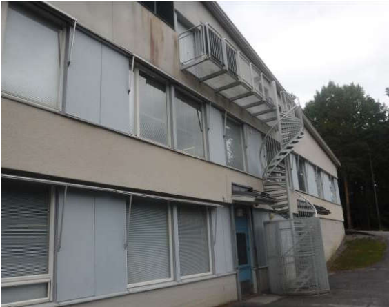
Teräksiset kierreportaat iv -konehuoneeseen
