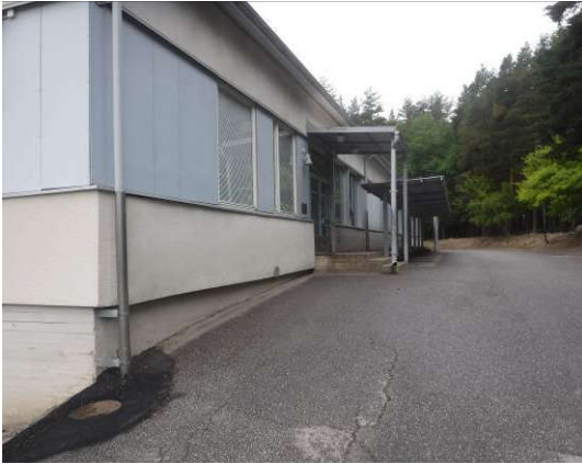
Takapihan puoleista julkisivua ja rakennuksen vierustaa; kallistuksissa ei puutteita
