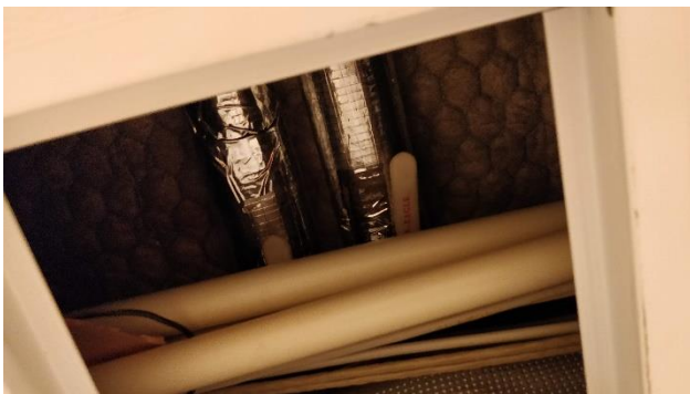
Kuva 11. Alas laskettujen kattojen yläpuolella ja koteloissa havaittiin villaeristeisiä putkia ja iv-kanavia.
