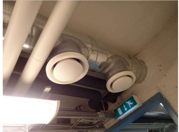
Poistoilmaventtiileitä
