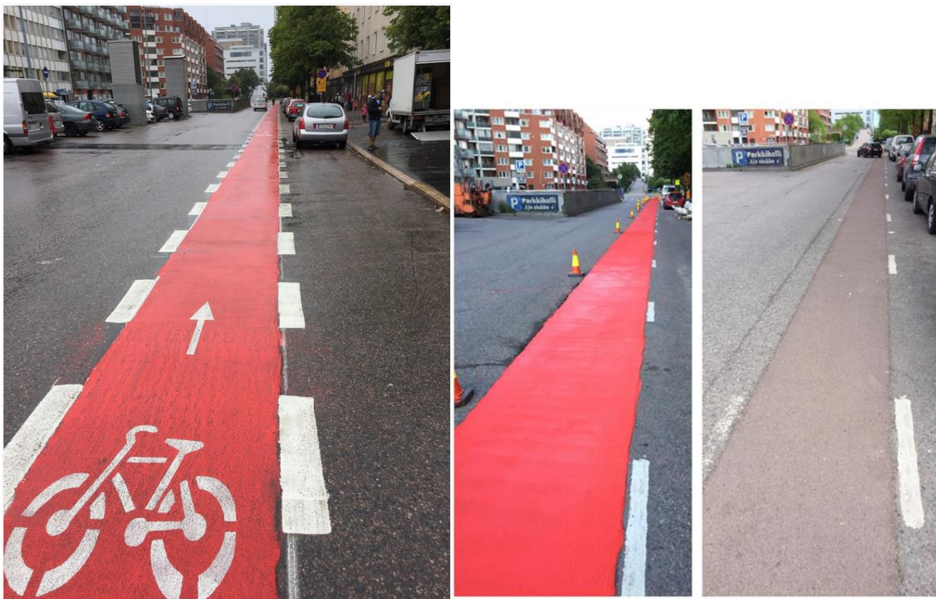
Kuva 4. Vasemmalla Barrikade Traffic pyöräkaistamerkintä Helsingissä sadepäivänä. Pyöräilijän turvallisuus paranee, kun kaistamerkintä erottuu selvästi. Keskellä juuri asennettu Barrikade Traffic ja ennen pinnoitusta oleva tilanne oikealla. Helsinki. (Lähde: Fidocol Oy)
