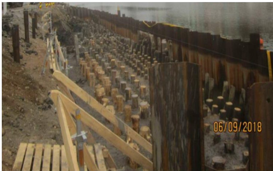
Kuva 7. Valokuva vedettömäksi tehdystä rantamuurin perustustyömaasta.
