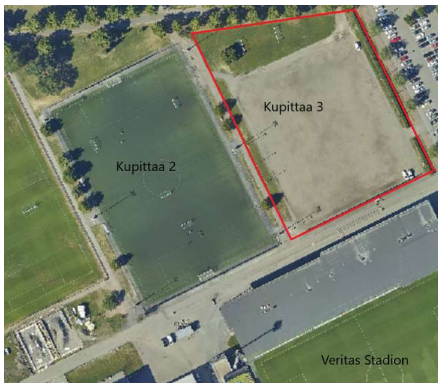
Bild 1. Allmän beskrivning av området
