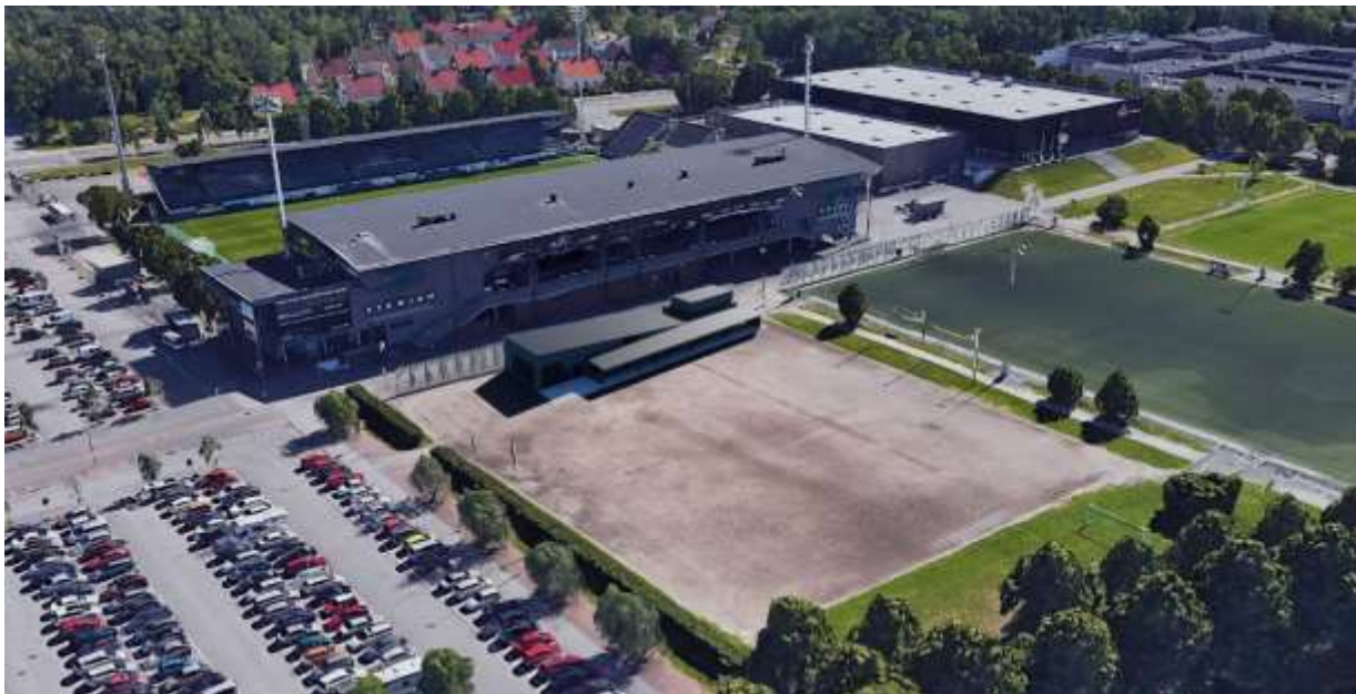
Bild 8. Flygbild på servicebyggnaden
