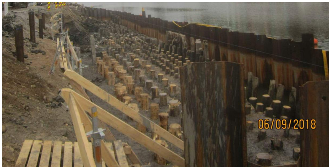
Bild på vattenfri byggarbetsplats för grundläggning av strandmuren.
