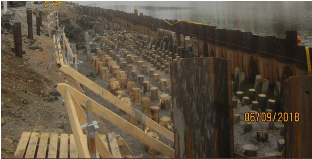
Valokuva vedettömäksi tehdystä rantamuurin perustustyömaasta
