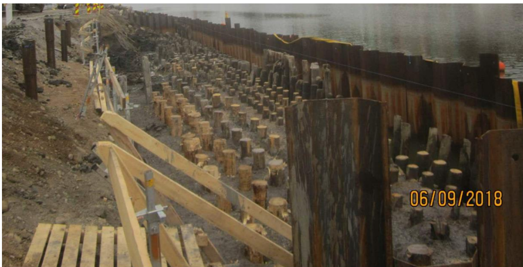
Valokuva vedettömäksi tehdystä rantamuurin perustustyömaasta
