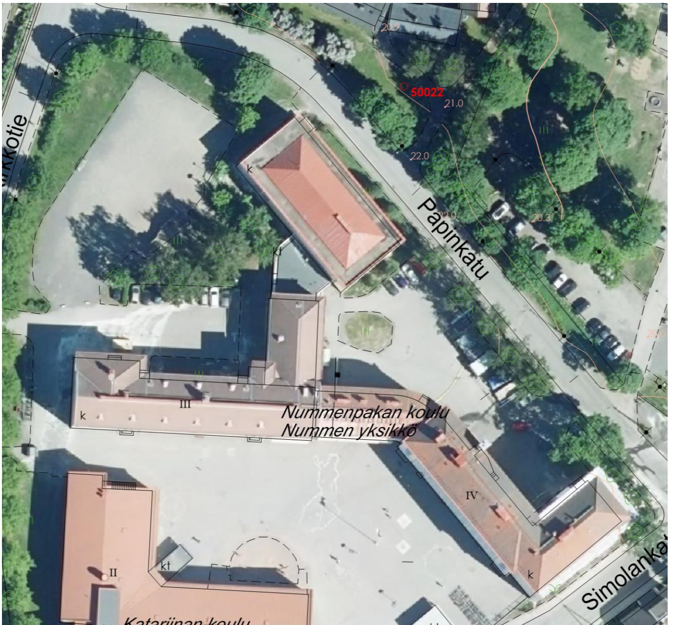
Bild 1. Skolbyggnaderna och gymnastiksalen som ombyggs
