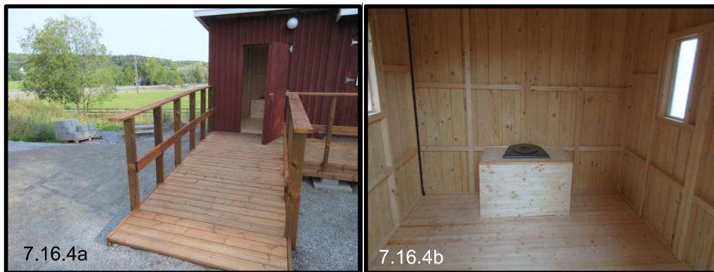
Kuva 7.16.4a Hyvä ratkaisu: Esteettömään puu-ceehen on leveä ja loiva luiska sekä leveä, kynnyksetön ovi. (Kuralan kylämäki)
