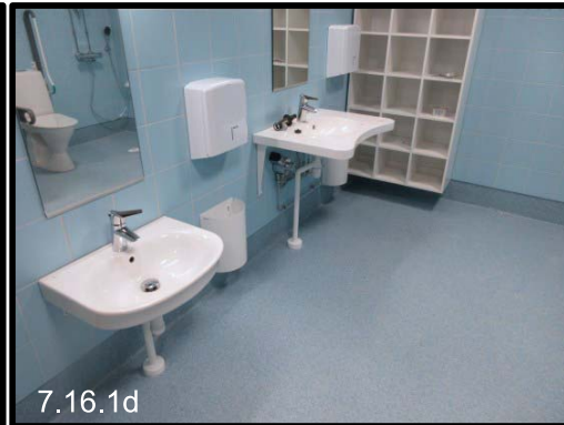
Kuva 7.16.1d Hyvä ratkaisu: Lapsille suunnatussa kohteessa on eri korkeuksilla olevia käsi- ja roskastiat. Käsi- ja roskastiat ovat myös eri korkeuksilla ja suoraan niiden alapuolella on seinään kiinnitetyt kiinteät roskastiat. Roskastian ja käsi- ja roskastian välissä on sopiva tila molempien kalusteiden käyttämiseen (suositellaan 350 mm:n korkeutta niiden välissä). Wc-tilassa on myös runsaasti tilaa. (Tallimäen päiväkot)
