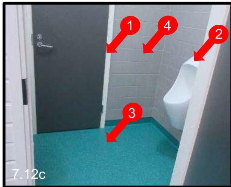
Kuva 7.12c Hyvä ratkaisu: [1] Ovet ja [2] wc-kalusteet erottuvat [3] lattiasta ja [4] seinistä kontrastierojen avulla. (Ypsilon)
