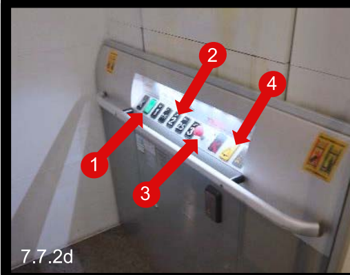
Kuva 7.7.2c Hyvä ratkaisu: [1] Näppäimissä on kohokuviot. [2] Hississä on hyvin erottuva hälytyspainike sekä [3] hätäpysäytyspainike. (Topeliuksen koulu, Hansakadun yksikkö)
