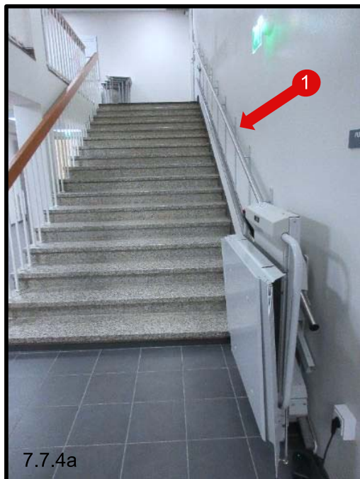
Kuva 7.7.4a Hyvä ratkaisu: [1] Porrasnostin kiinnitetty suoraan seinään. Nostimen lepötila on alhaalla. (TSYK)
