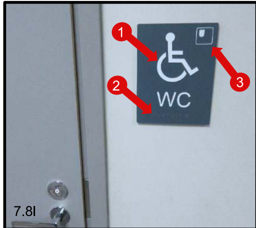
Kuva 7.8l Hyvä ratkaisu: Esteetön wc-tila on merkitty suurikontrastisella kuvallisella [1] koho-opasteella, jossa on myös [2] pistekirjoitusta. [3] Lisäksi LE-wc-tila on vain oikealta puolelta käytettävä, mikä on merkitty oikeaan yläkulmaan. [4] Sukupuolineutraalin wc:n merkintä. (TSYK)
