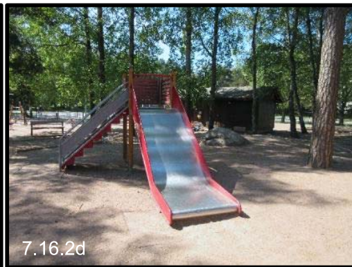
Kuva 7.16.2c Hyvä ratkaisu: [1] Liukumäki päättyy alle 100 mm:n korkeudelle maanpinnasta. (Parolanpolun päivähoito)
