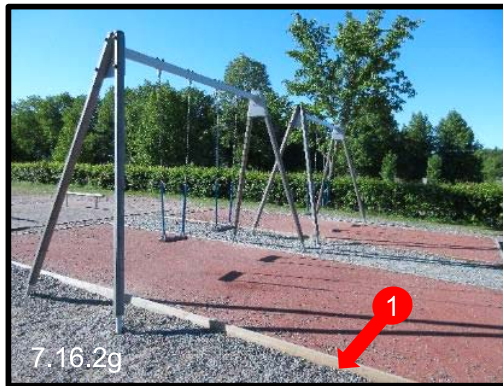
Kuva 7.16.2g Hyvä ratkaisu: [1] Keinujen alla turva-alusta, joka rajaa alueen väri- ja tuntokonstrastilla (alusta on koholla ja alustan materiaali poikkeaa ympäristöstään). (Pansion koulu)
