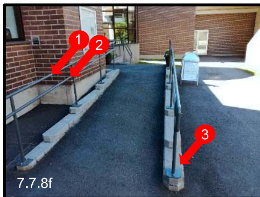
Kuva 7.7.8f Hyvä ratkaisu: Luiska on loiva, [1,2] käsijohteet ovat kahdella eri korkeudella. [3] Huomaa myös luiskan suojaeuna. (Varissuon kirjasto)
