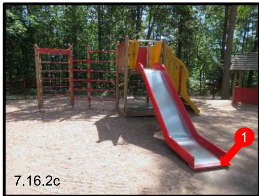
Kuva 7.16.2c Hyvä ratkaisu: [1] Liukumäki päättyy alle 100 mm:n korkeudelle maanpinnasta. (Parolanpolun päivähoito)
