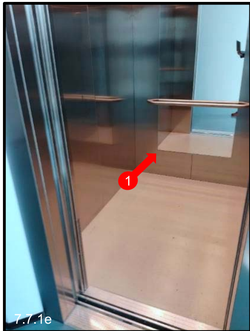
Kuva 7.7.1e Hyvä ratkaisu: [1] Hissikorin takaseinälle sijoitettu peili helpottaa pyörätuolinkäyttäjän poistumista hissistä tilanteessa, jossa hissi ei ole läpikuljettava. (Toimeentulon neuvonta, Turun kaupunki)
