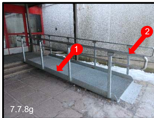
Kuva 7.7.8f Hyvä ratkaisu: Luiska on loiva, [1,2] käsijohteet ovat kahdella eri korkeudella. [3] Huomaa myös luiskan suojaeuna. (Varissuon kirjasto)
