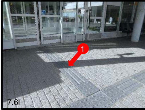
Kuva 7.6l Hyvä ratkaisu: [1] Opasteraita ohjaa sisäänkäynnille. (Mäntymäen terveysasema)
