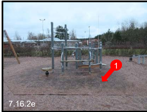
Kuva 7.16.2e Hyvä ratkaisu: [1] Kiipeilytelineen alla on turva-alusta. (Nummenpakan koulu, Halisten yksikkö)
