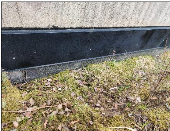
Kuva 5.3. Itäisivun sokkeliä on korjattu.
