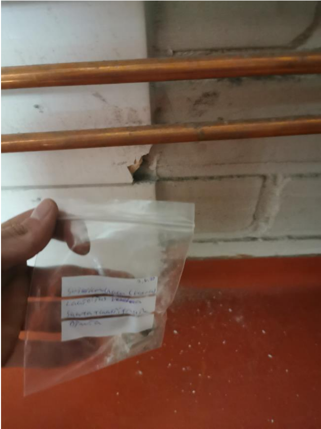
Kuva kohteen vaalean laatoituksen näytteestä.
