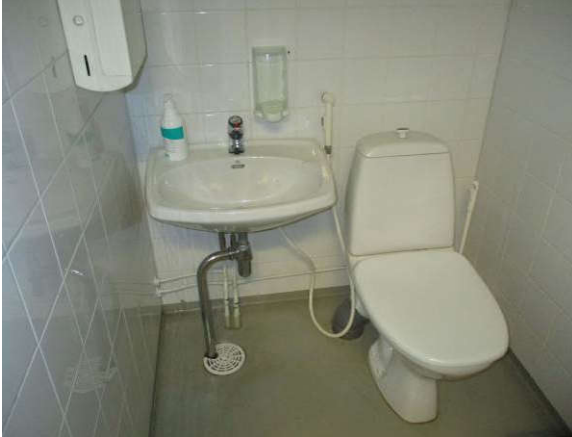
Vesi- ja viemärikalustusta
