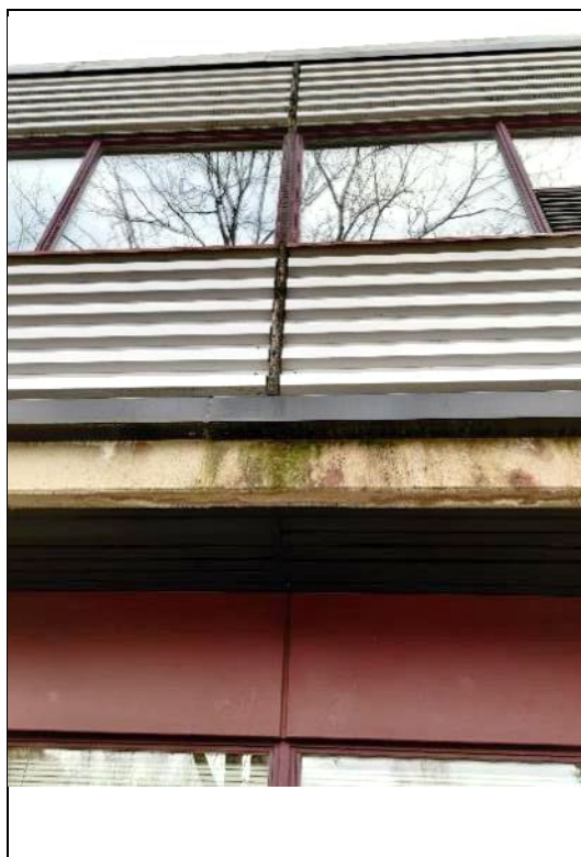
Kuva 5.8. Luokkasiiven pitkällä julkisivulla on kosteusrasituksen jälkiä.
