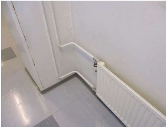
Lämpöjohdot ovat perinteisiä teräsputkiasennuksia
