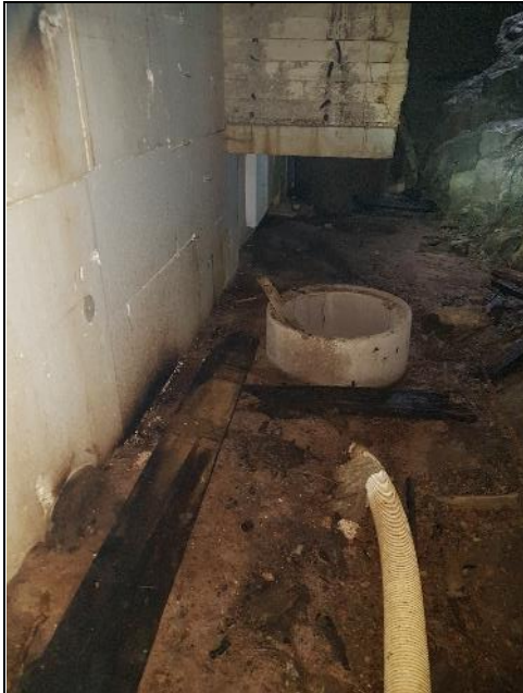
Kuva 5.80. Salaojat kulkevat maanpinnan yläpuolella. Maa on märkää salaojien ympärillä, mutta salaojissa ei virtaa vesi.
