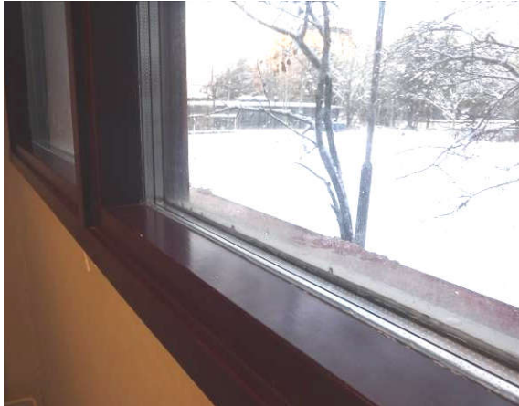
Ikkunoissa on lämpölaselementit
