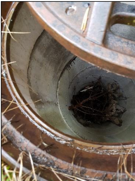
Kuva 5.81. Sadevesikaivo on tukittu oksilla yms.
