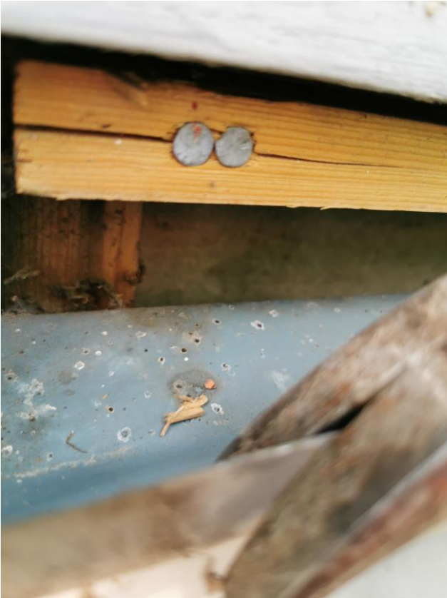
Kuva julkisivun asbestipitoisesta lujalevystä.
