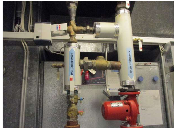
Toimilaitteet ovat osin alkuperäisasennuksia
