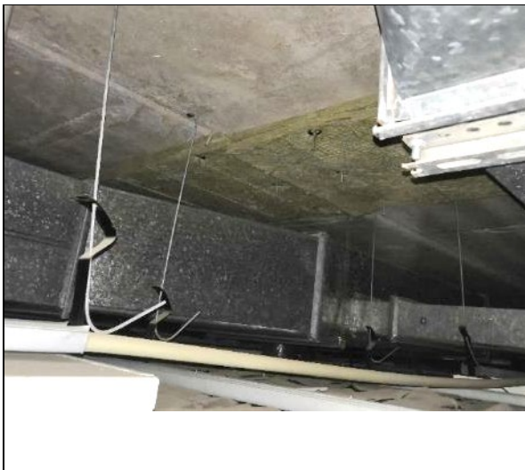
Kuva 5.74. Alakaton päällä on paikoin paljaita mineraalivillaeristeitä
