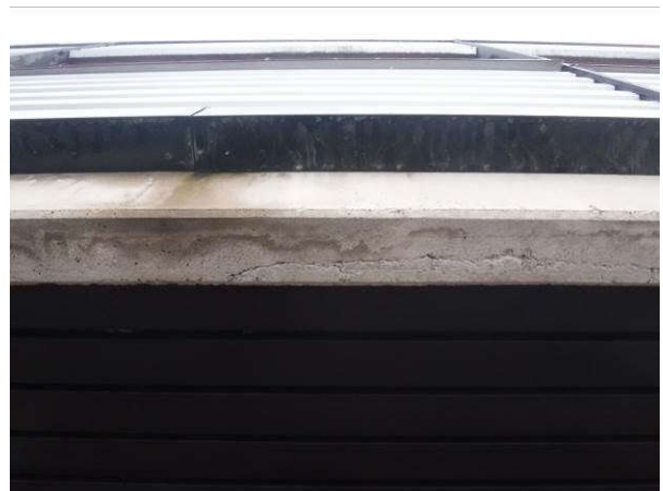
Betonipalkkia alhaalta kuvattuna
