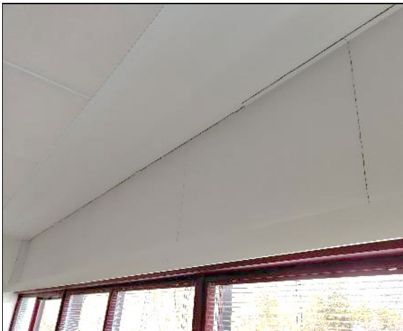
Kuva 5.38. Halkeamia luokkasiiven ensimmäisen kerroksen levyrakenteisessa ulkoseinässä (luokka 111).
