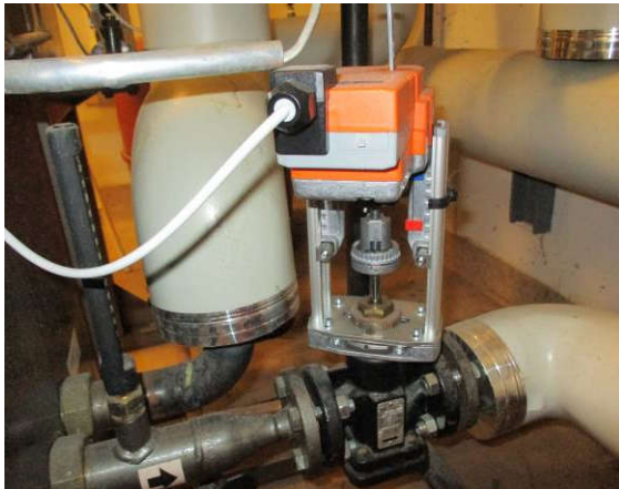
Lämmönjakokeskuksen toimilaitteita on uusittu
