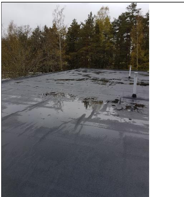
Kuva 5.55. Luokkasiiven vesikatolle lammikoituu vettä.
