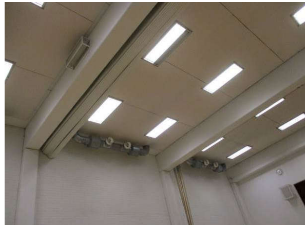
Ilmanvaihtolaitteita liikuntasalin katon rajassa
