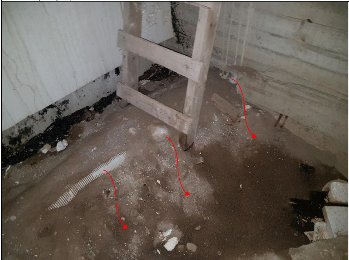
Kuva 5.23. Sulkutilasta on merkittäviä ilmavuotoja liikuntasauoista sekä pilariliittymistä (kuva liikuntasalin itäpäädyssä).
