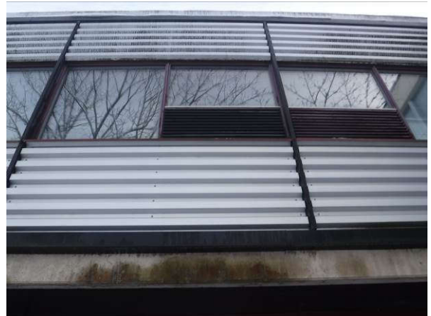
Betonirakenteeseen kohdistuu ylimääräinen kosteusrasitus ylhäältä valuvista sadevesistä
