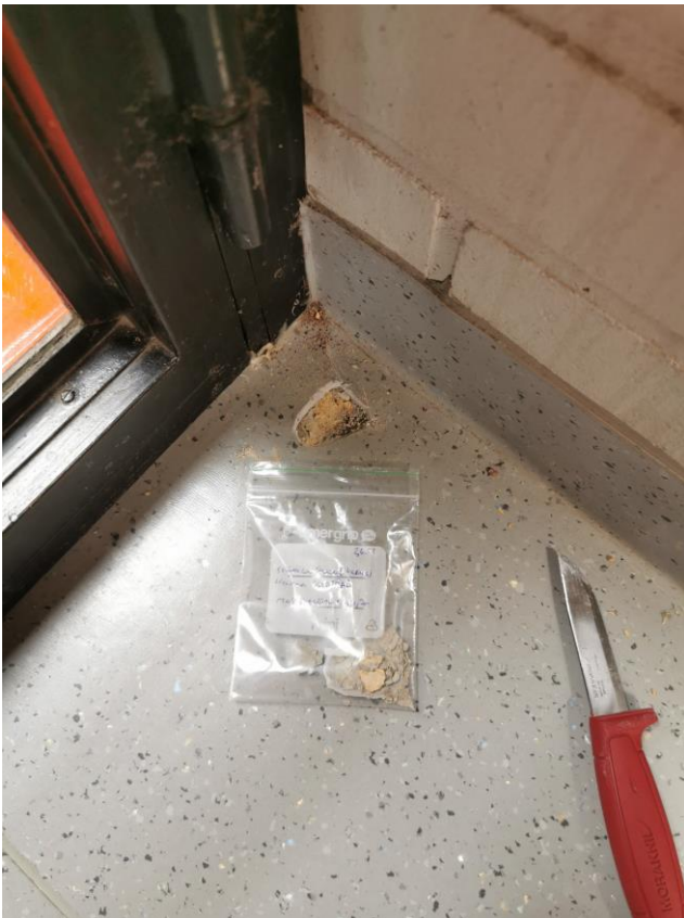
Kuva käytävän lattian näytteen otosta.
