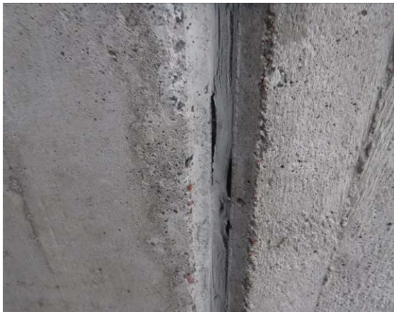
Liikuntahallin sokkelin elastisissa saumauksissa on halkeamia
