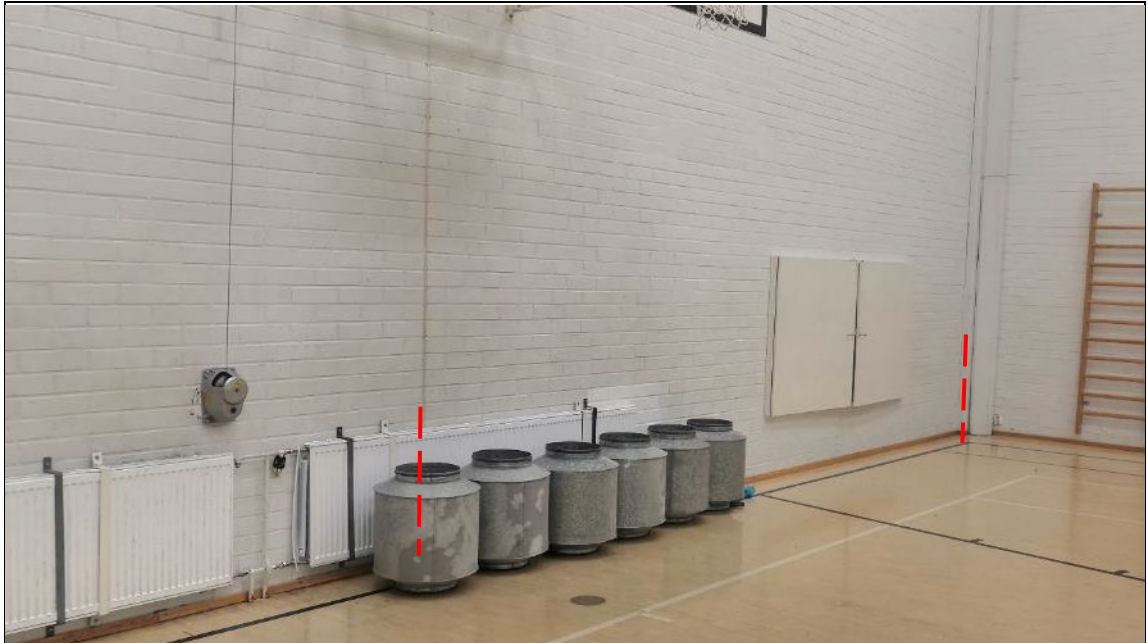
Kuva 5.23. Sulkutilasta on merkittäviä ilmavuotoja liikuntasauoista sekä pilariliittymistä (kuva liikuntasalin itäpäädyssä).
