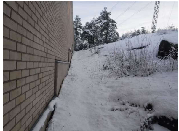
Liikuntahallin takaosan vierustaa
