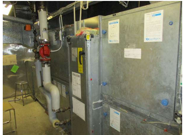
Liikuntasalin ja pukutilojen ilmanvaihtokone
