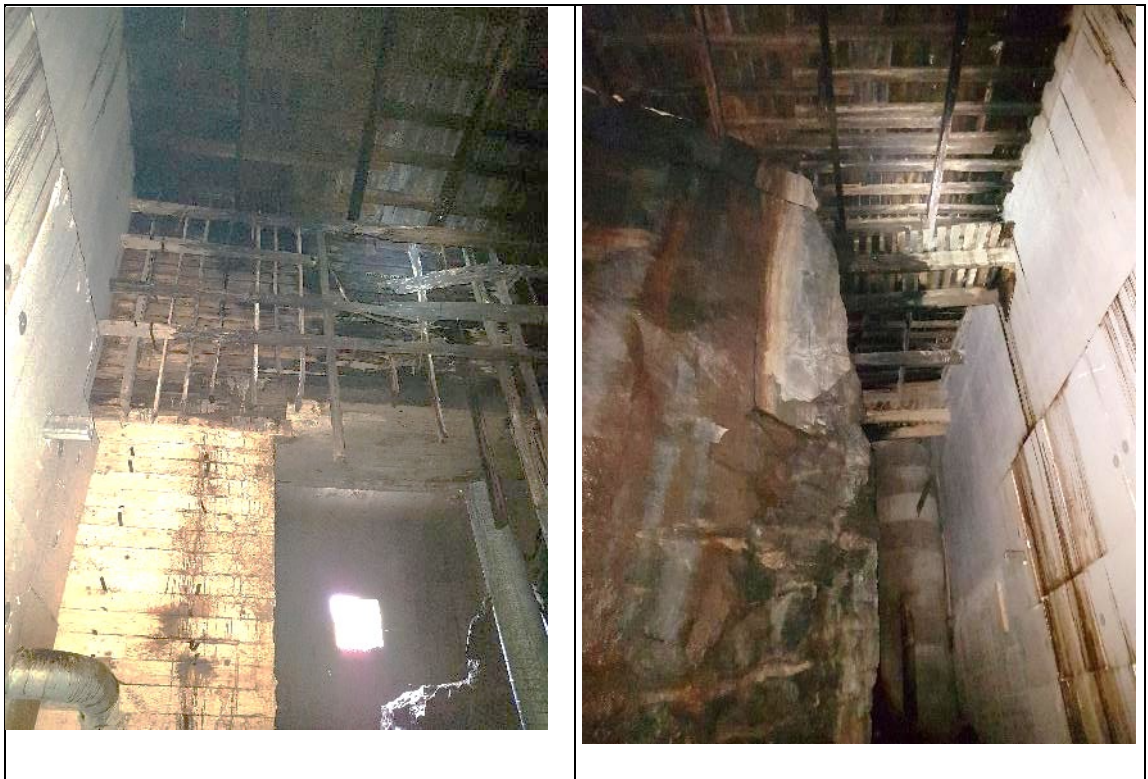
Kuva 5.20. Sulkutilassa on lahonneita muottilaudoituksia.
