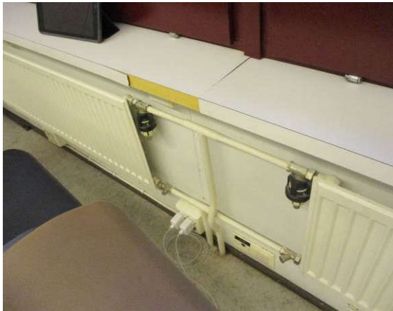
Patteriventtiin ovat pääosin alkuperäisasennuksia
