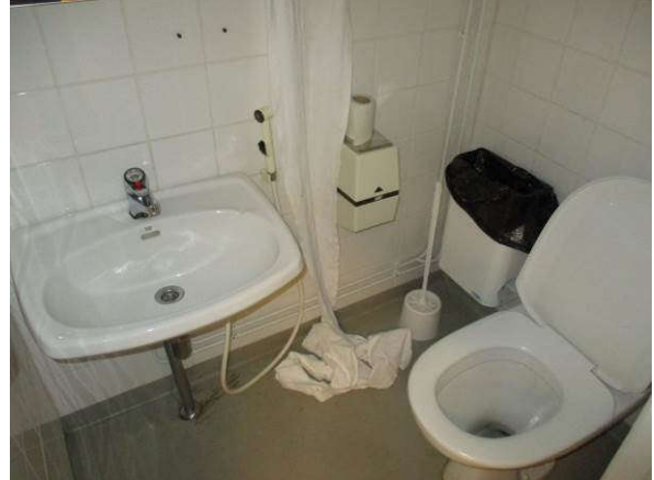
Vesi- ja viemärikalustusta
