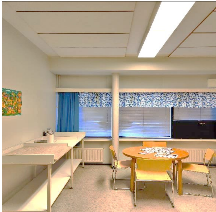
Kuva 5.75. Terveydenhoitajan tilojen katossa on reunoiltaan pinnoittamattomia akustiikkalevyjä.
