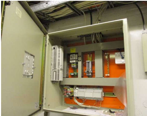
VAK-kaappi lämmönjakuhuoneen seinällä
