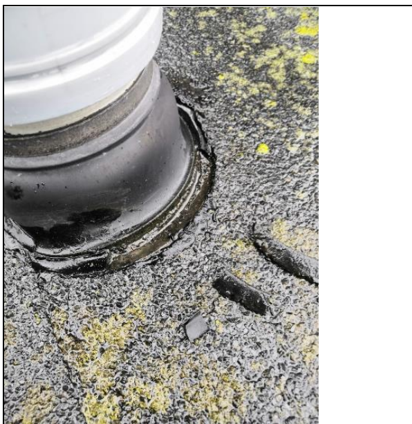
Kuva 5.56. Luokkasiiven läpivientien tiivistykset ovat hapertuneet.
