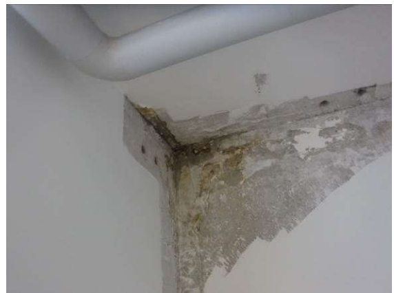
Kosteusvaurio pohjakerroksen ulkoseinässä
