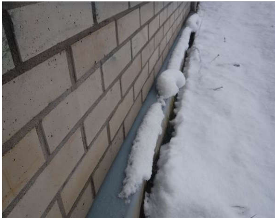
Liikuntahallin sokkeliä ylärinteen puolella; sokkelin yläpinnassa suojapelti
