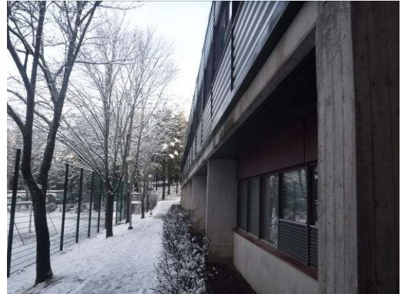
Takasivua; vierusta tasainen
