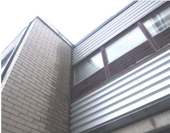
Suojapellitykseltä valuva sadevesi kastelee kalkkihiiekkakivimuurausta ja sisänurkkaa
