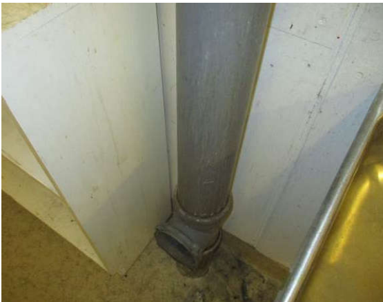
Viemärit ovat muovia
