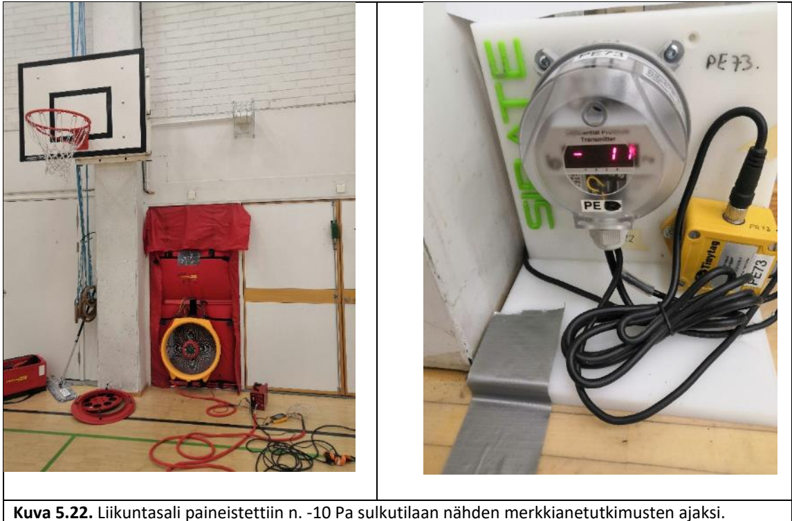
Kuva 5.22. Liikuntasali paineistettiin n. -10 Pa sulkutilaan nähden merkkiainetutkimusten ajaksi.
