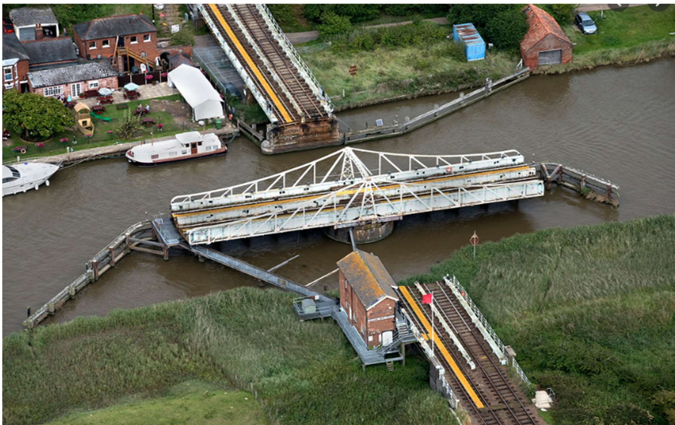
Flygbild över svängbrons funktionsprinciper
