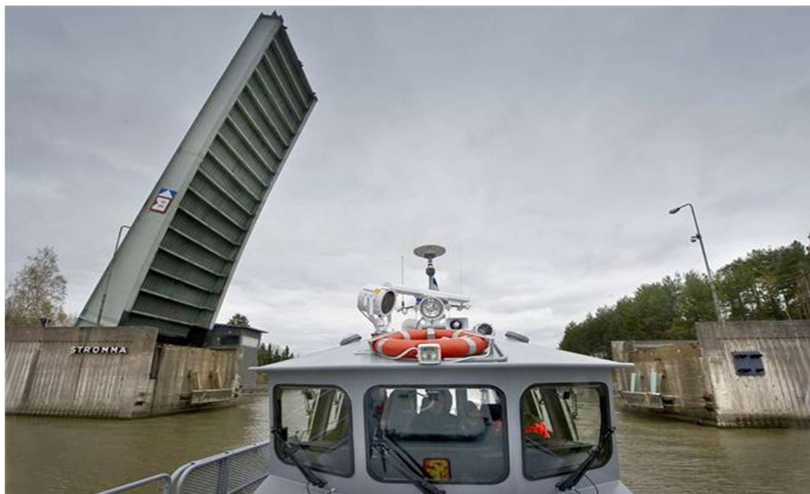
Lyftbron över Strömma kanal
