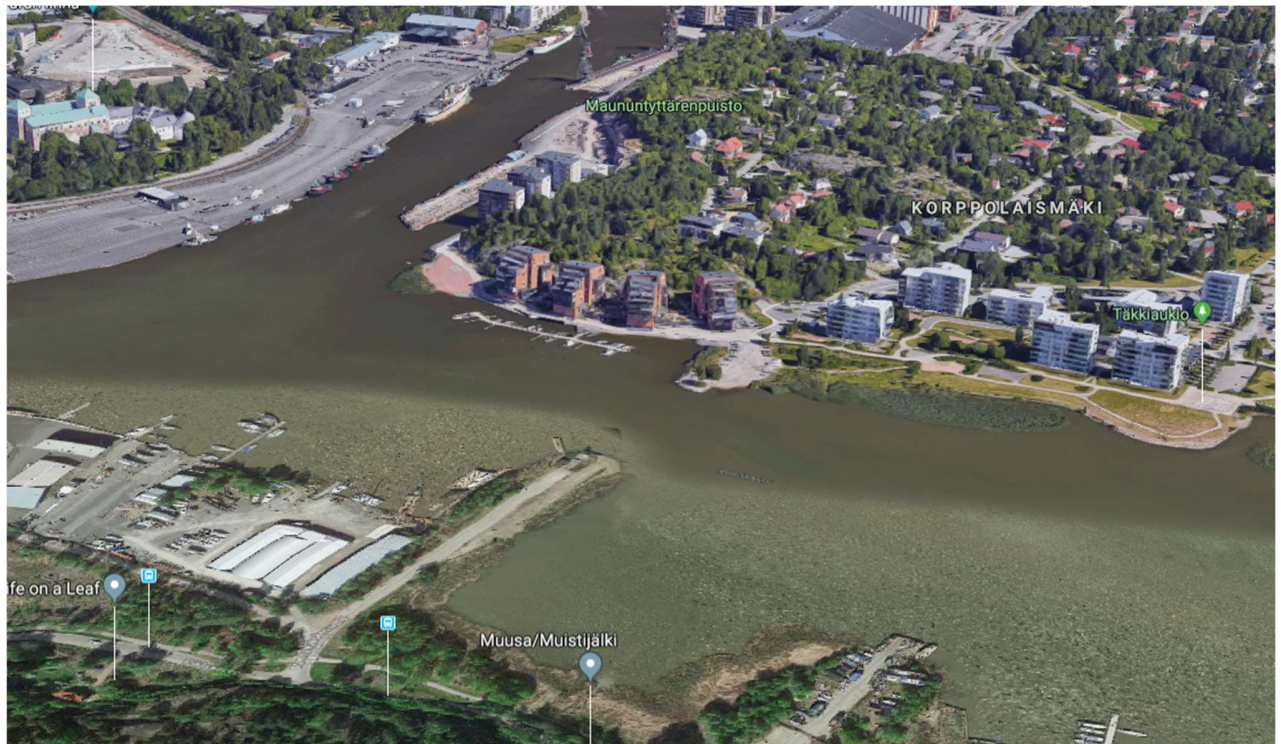
Flygbild över bygnadsområdet
