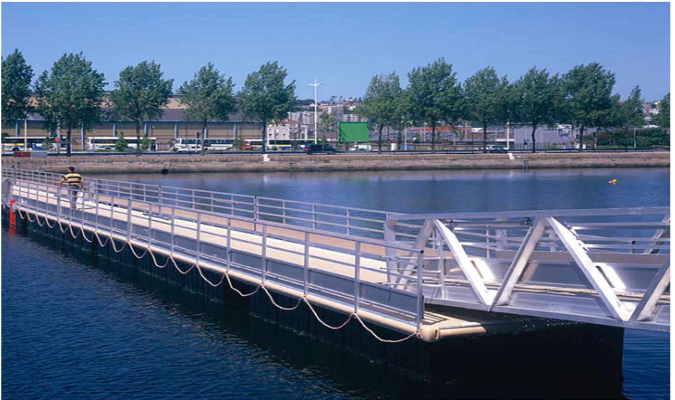
Ponttonisilta ja liityntäramppi
