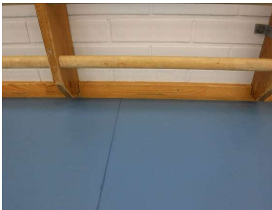
Liikuntasalin lattian ja seinän liittymää; jalkalistaan on asennettu tuuletusrakoja, joista ilmavirtaukset pääsevät lattiapinnoitteen alle
