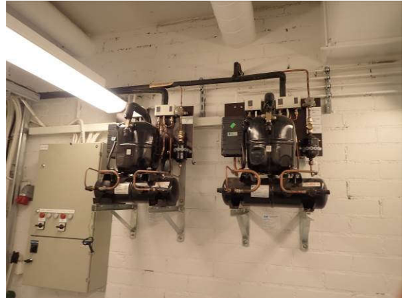
Keittiön kylmiöiden kompressorit
