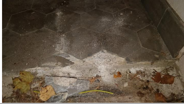
Kuva 2. B-siiven alakerran kuuskulmalaatoituksen laastit eivät sisällä asbestia.
