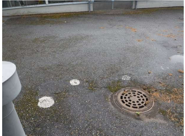
Pintavedet on ohjattu pääosin sadevesikaivoihin
