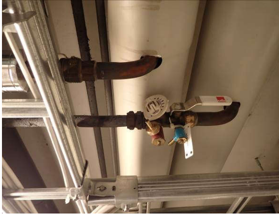
Linjasäätöventtiili
