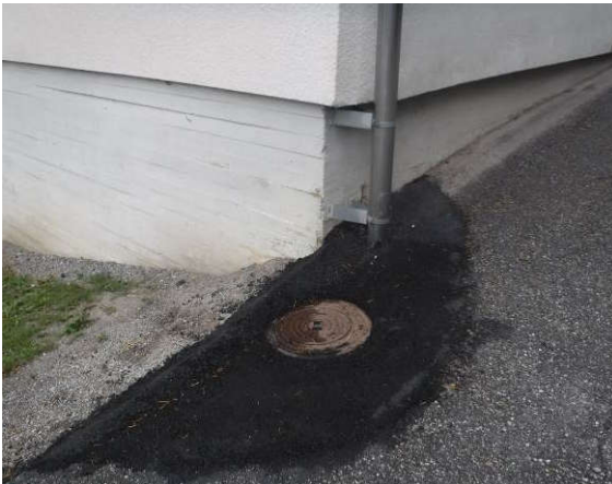
Kattovedet on ohjattu omaan poistojärjestelmään
