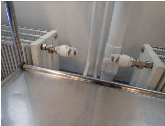
Patteriventtiileitä
