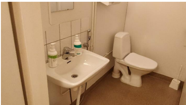
Kuva 9. B-siiven alkuperäiset seinälaittoitukset eivät sisällä asbestia.
