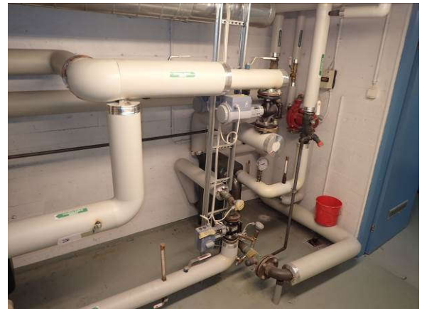
Käyttöveden lämmönsiirrin
