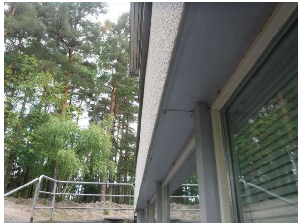
Julkisivua alhaalta kuvattuna
