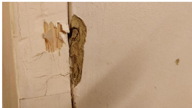
Kuva 4. Sementtilevy sisältää asbestia.
