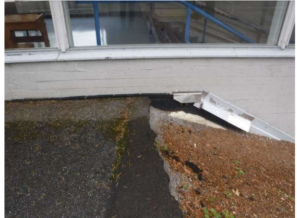
Alkuperäiset ikkunat ja vesipellit
