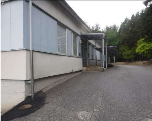
Takapihan puoleista julkisivua ja rakennuksen vierustaa; kallistuksissa ei puutteita
