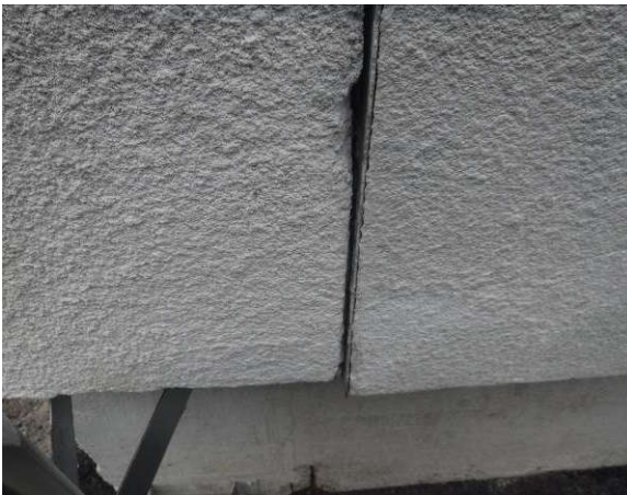
Julkisivussa oleva liikuntasäama
