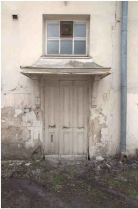
Ulko-ovi rakennuksen koillisivulla.
