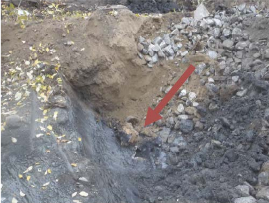
Kuva 5. Takapihalle hulevesikaivon alaosaan jouduttiin jättämään öljyistä maata (T64). Kuvassa näkyy myös vanhaa kellarista tullutta viemäriputkea, joka poistettiin ja jonka täyttöä pitkin öljyt olivat kulkeutuneet.
