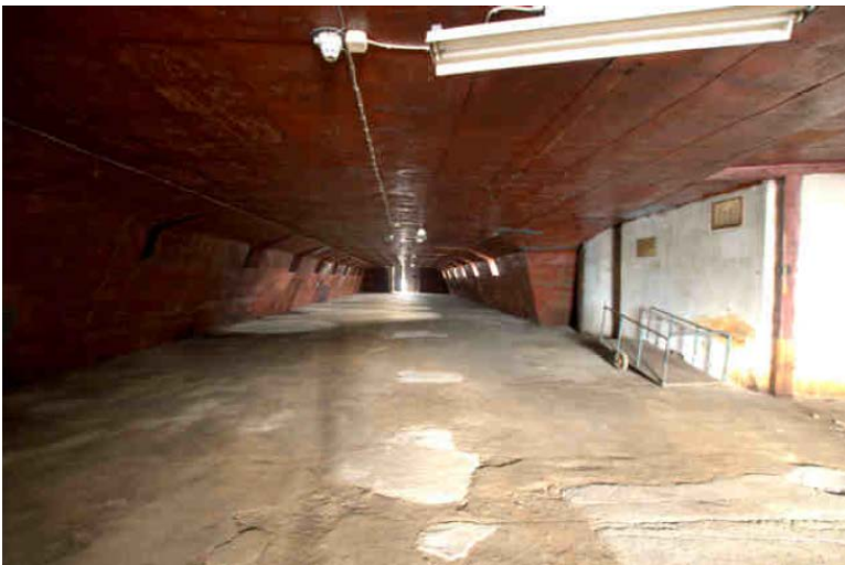
Ullakkotila, katto ja seinät vuorattu pellillä.
