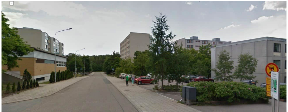
Kuva 14. Näkymä Kannuskadulta etelään, uimahallirakennus vasemmalla edessä
