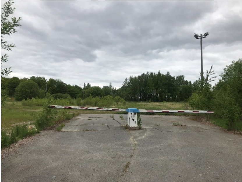
Kuva 4. Kiertotähdentien pääty, josta suunniteltu pääsy varikkoalueelle olisi. Kuva kesäkuu 2023.
