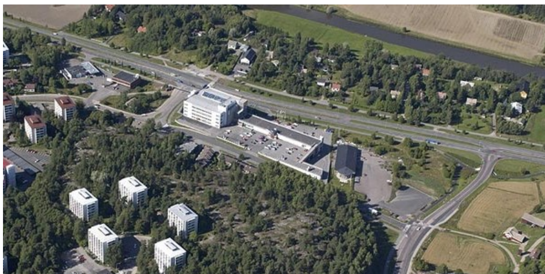
Kuva 2 Viistoilmakuva kaakosta (ennen asemakaava-alueen länsiosan korkeamman rakennuksen muuttamista Kulkurin Valssiksi) (Lähde: Turun kaupunki)
