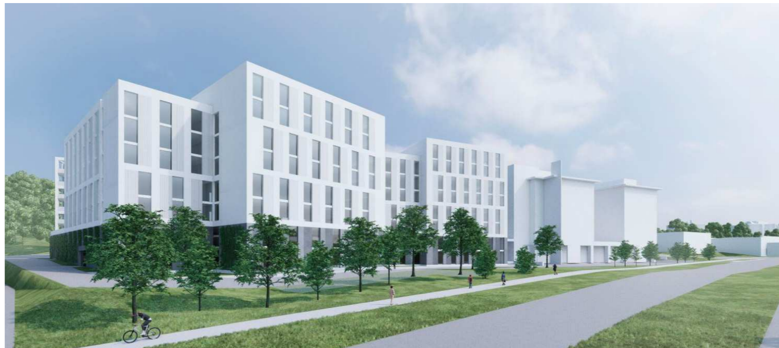
©TURUN KAUPUNKI (BM-ARCHITECTS)
