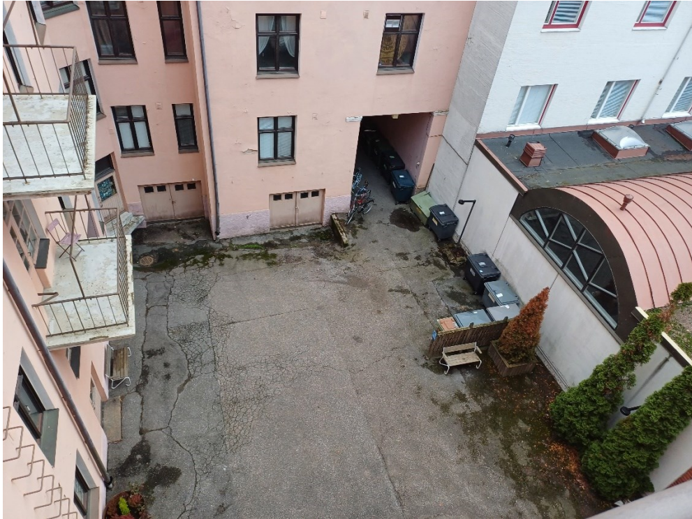
Kuva 3. Näkymä rakennuksen sisäpihalle tuuletusparvekkeelta. (valokuva 2023, Laura Virkki)
