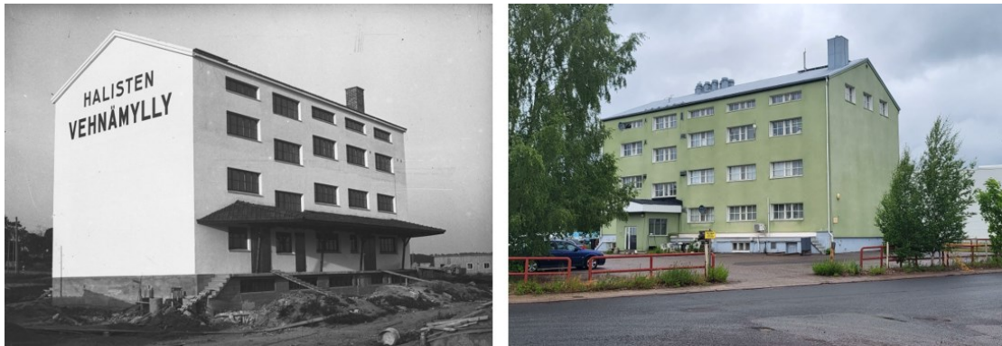
Kuva 7. Halisten vehnämylly vastavalmistuneena vuonna 1944 ja nykytilassaan 2023 (Rakennushistoriaselvitys Rautakatu 5).
