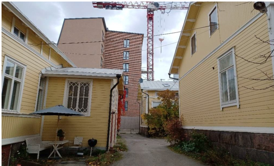
Kuva 5. Pihapiiriä (Rakennetun kulttuuriympäristön inventointi, Ramboll Finland Oy, 2021).
