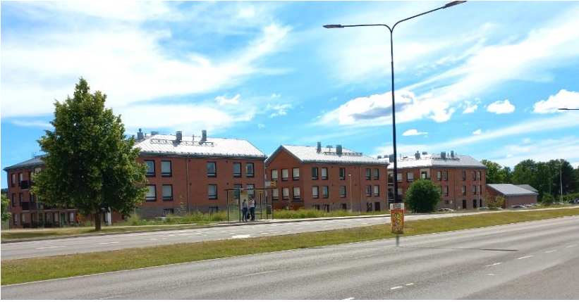
Kuva 2 Suunnittelualueelle vuosina 2021–2022 rakennetut kolmekerroksiset kerrostalot Satakunnantieltä päin. Kuva: Turun kaupunki, 2022.
