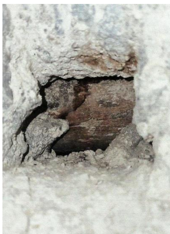
Kuva 10. Muottilautoja ulkoseinärakenteessa, CONTRO Oy , 18.12.2020
