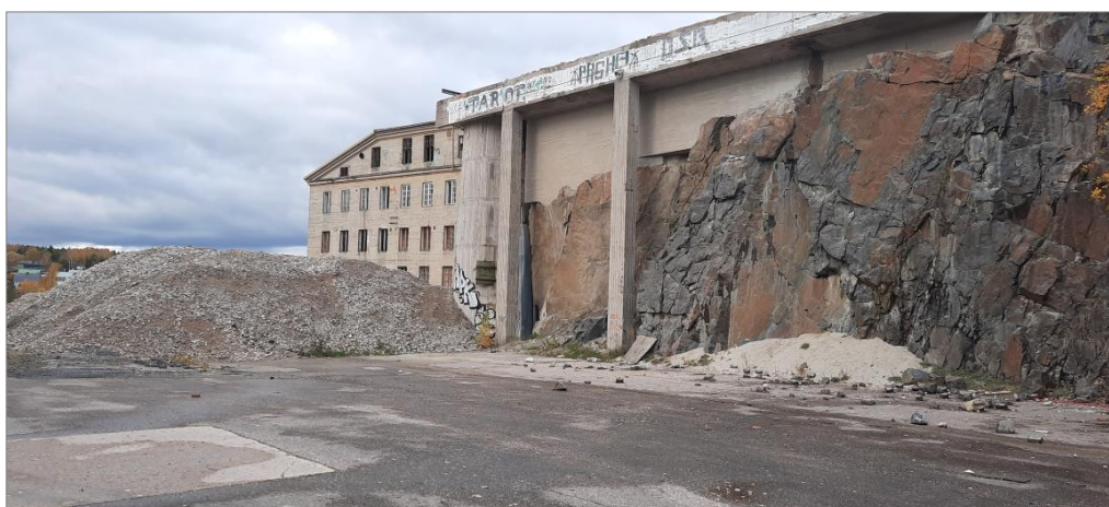
Kuva 4. Massalaitos ja viereinen kallioalue eteläsuunnasta, KAAWA Oy 11.10.2022.
